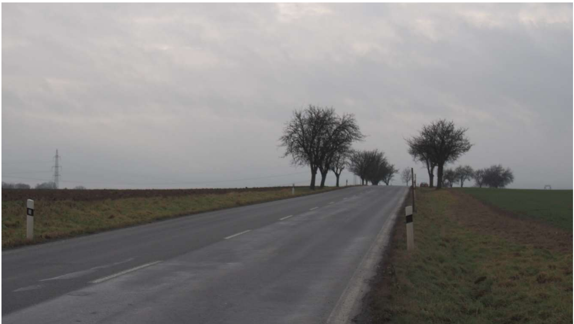
Obr.4 – Pohled na silnici III/04734 v místě budoucí ÚK (resp. MÚK) Suchdol nad Odrou
