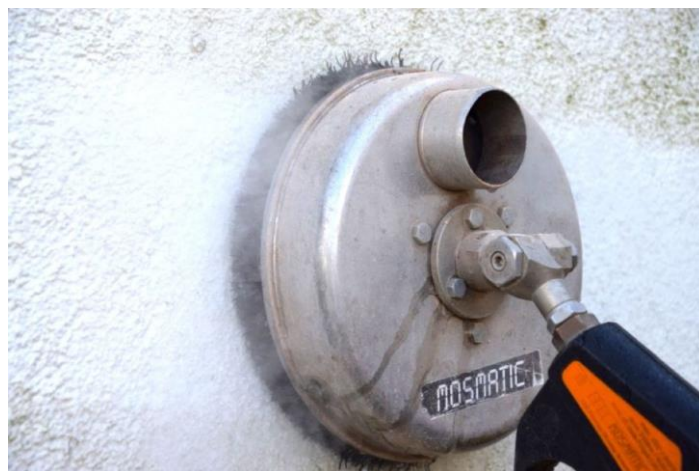
Obr. 16 Parní čištění fasády [zdroj: 39]
