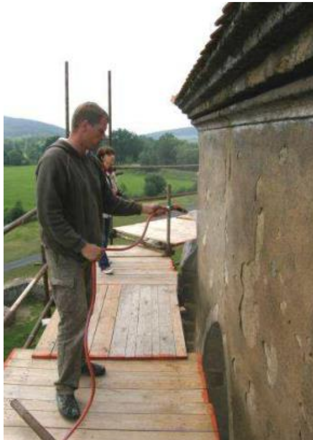
Obr. 18 Aplikace konsolidantu postřikem [zdroj: 16]
