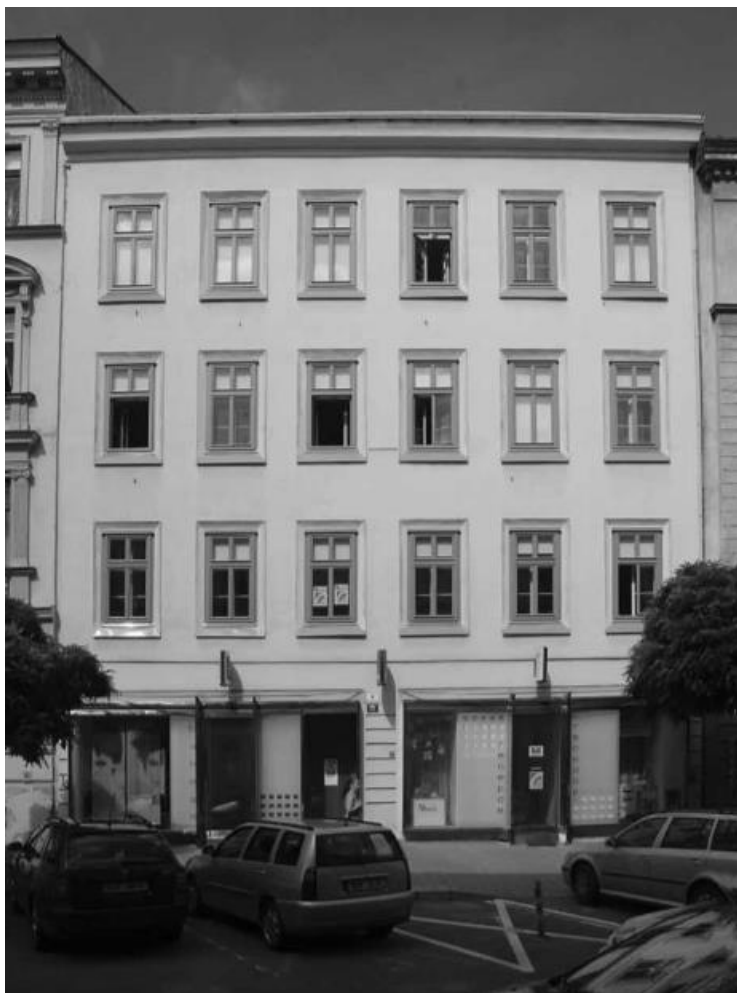
Obr. 25 Stupeň členitosti 1: „Hladká omítka rovných nebo oblých ploch s jednoduchou hlavní římsou, případně kordonovou.“ [zdroj: 20]
