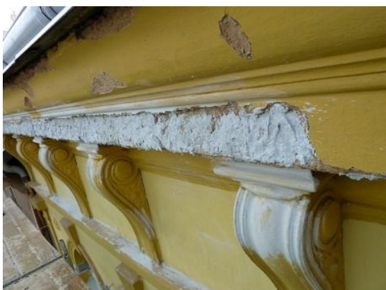
Obr. 20 Římse před opravou [zdroj: 17]
