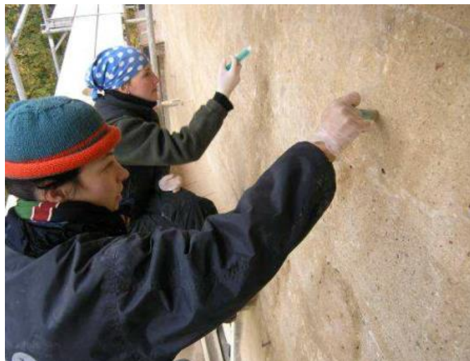
Obr. 19 Injektáž dutin pod omítkou [zdroj: 16]
