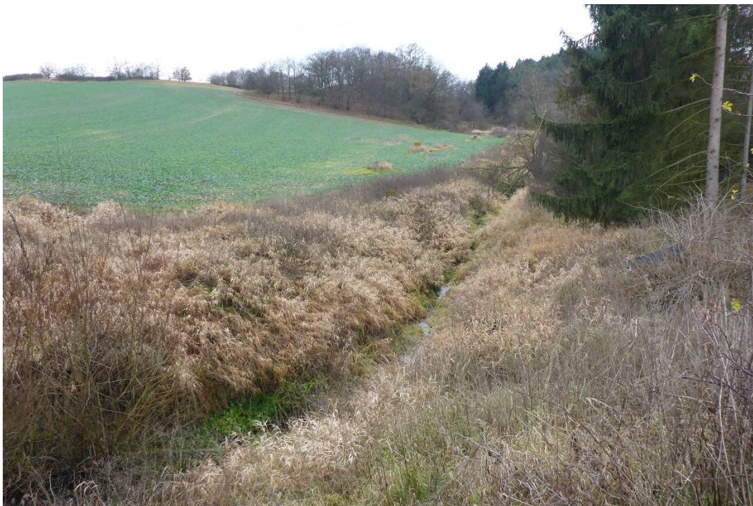
Obr. 11 Úsek napřímeného Mehelnického potoka, pohled na šachty stávající kanalizace
