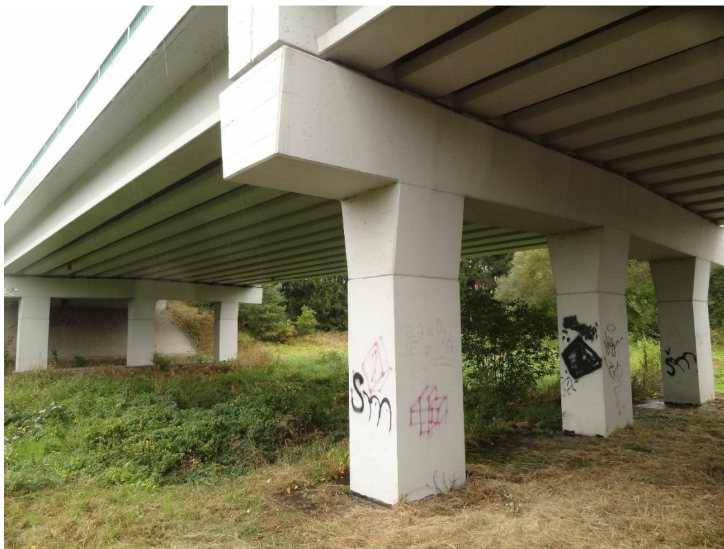
Obr. 9 Pilíře silničního mostu silnice I20
