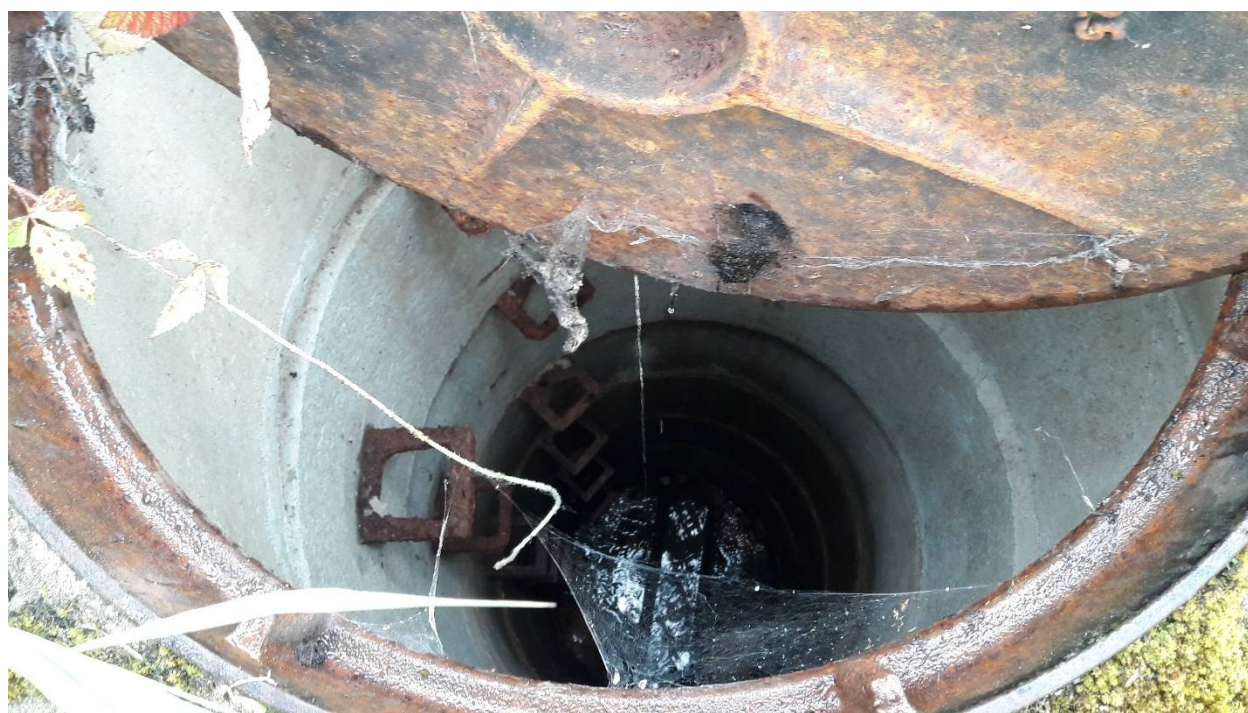
Obr. 16 Detailní pohled do kanalizační šachty vedoucí podél Mehelnického potoka
