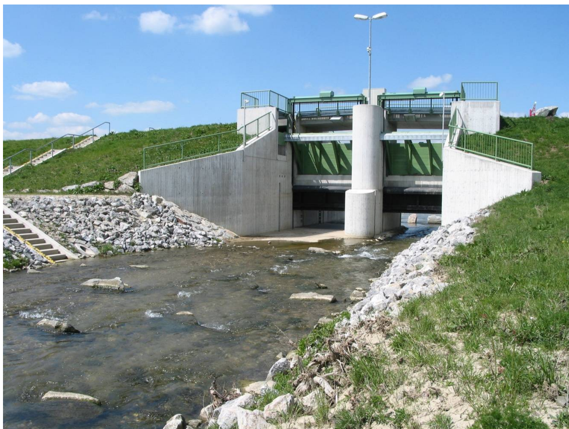
Obr. 1 Sružený objekt suché nádrže - Protipovodňová opatření nad obcí Dirlewangem [3]
