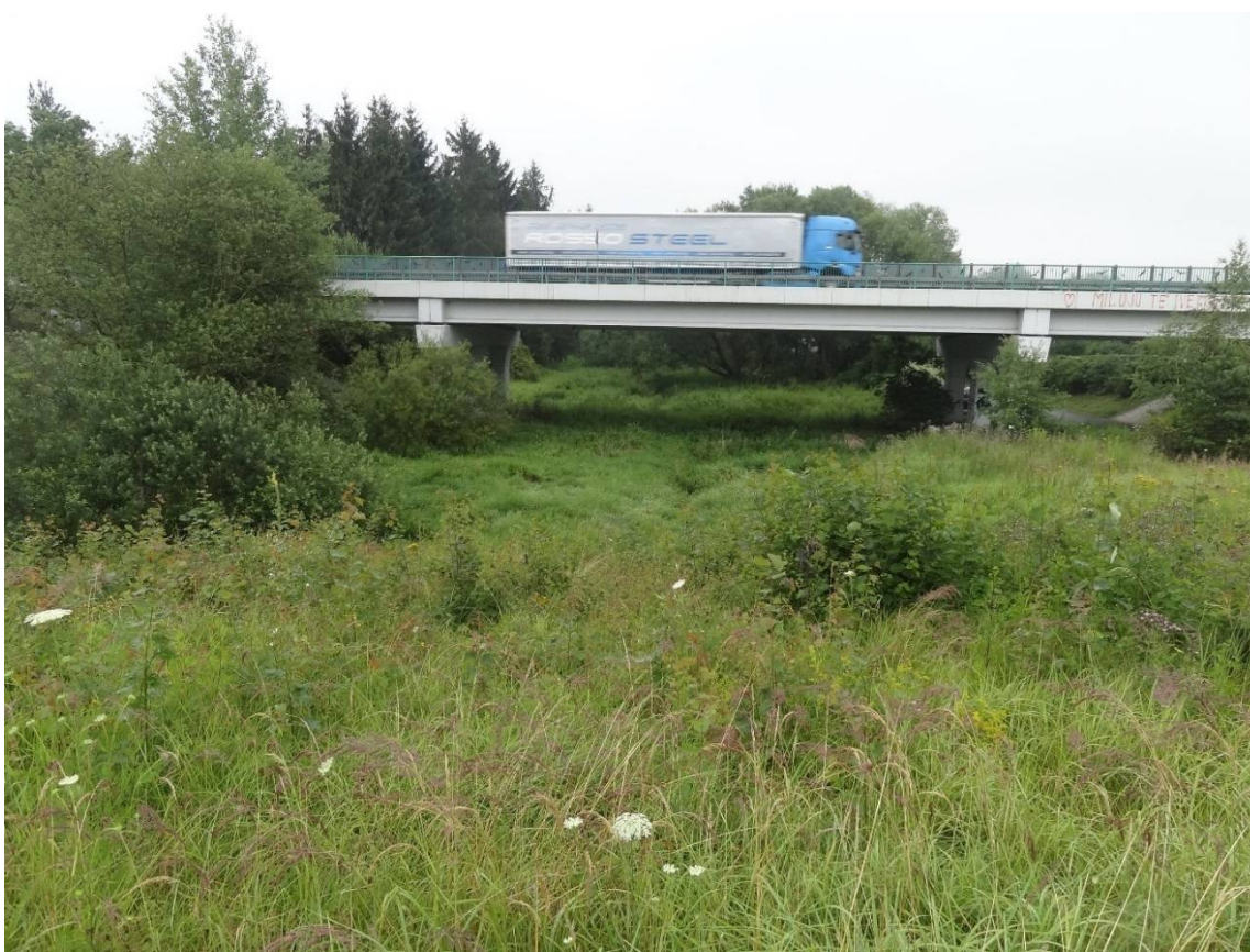
Obr. 8 Pohled do oblasti bývalého rybníka, pod silničním mostem silnice I20
