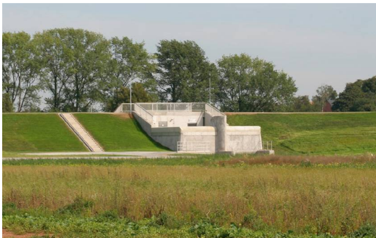
Obr. 6 sdužený objekt nádrže – protipovodňová ochrana města Niederberg [7]
