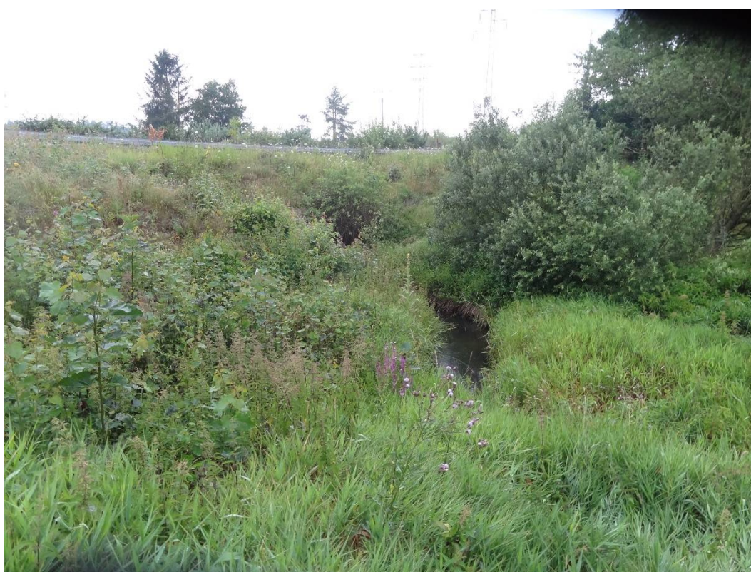
Obr. 10 Propustek pod komunikací III. třídy
