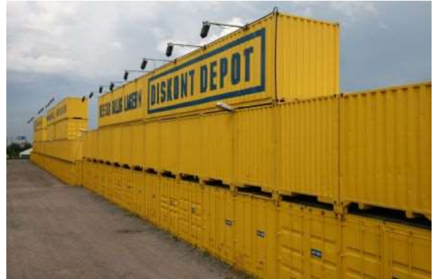
DEPO self-storage, AT-Vídeň (CONTAINEX Container-Handelsgesellschaft m.b.H.)
