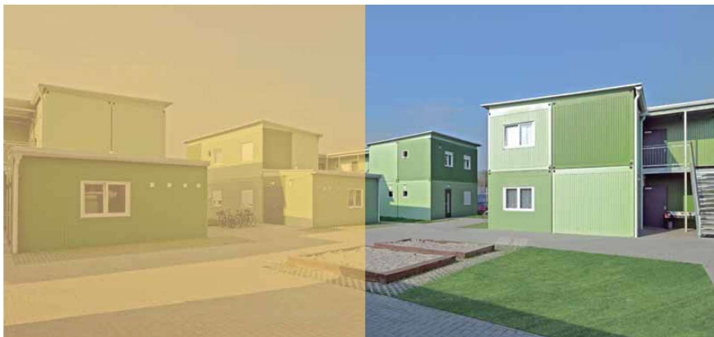
Přechodná ubytovna v Brémách (Algeco.)
