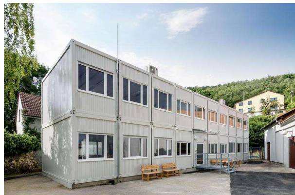
Výstavba základní školy, Praha-Velká Chuchle, 2017 (Algeco.)
