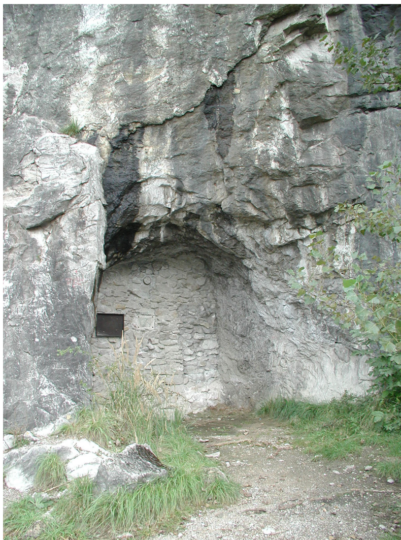
Obrázek 3.7: Pohled na uzavřený vchod do úložiště [19]
