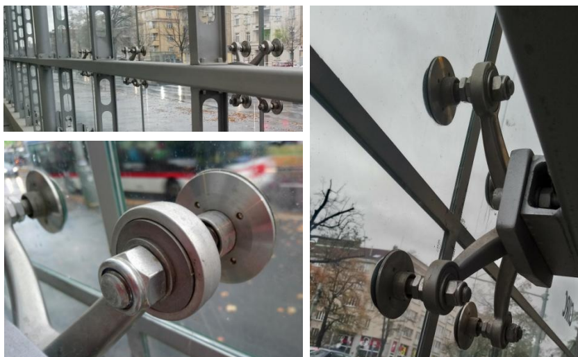
Obr. 4 Příklad připojení pomocí bodových podpor
