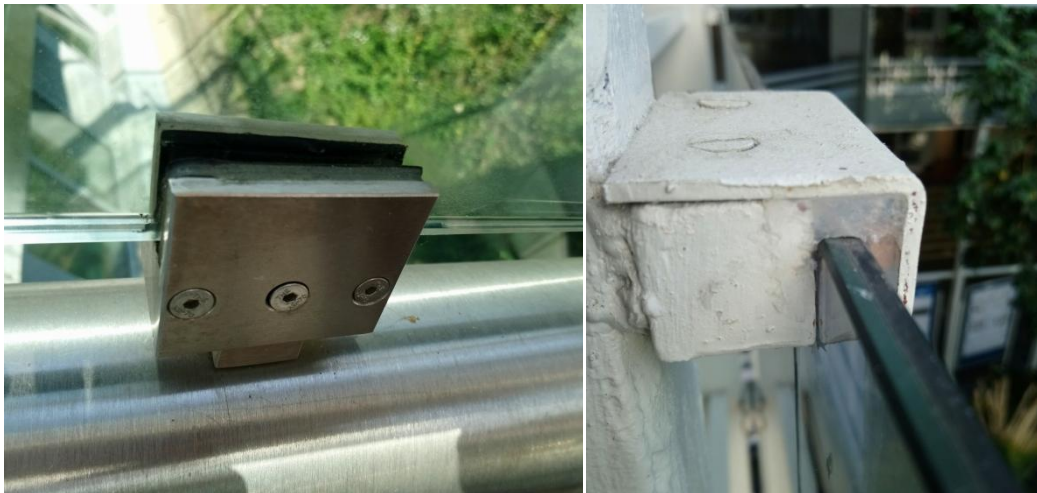
Obr. 3 Příklad příklady připojení pomocí lokálního upnutí
