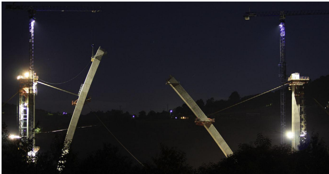
Obrázek 22 - River Deza viaduct - sklápění lomeného oblouku [26]
