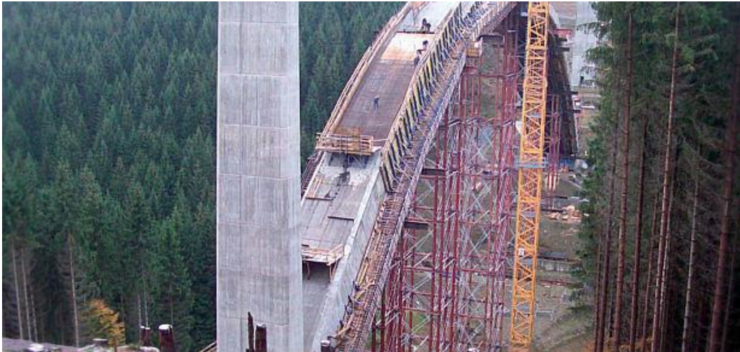
Obrázek 20 - Massetalbrücke - skruž oblouku [70]
