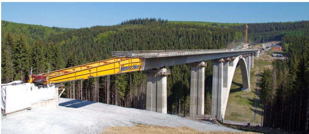
Obrázek 19 – Massetalbrücke – výsuv nosné konstrukce [61]
