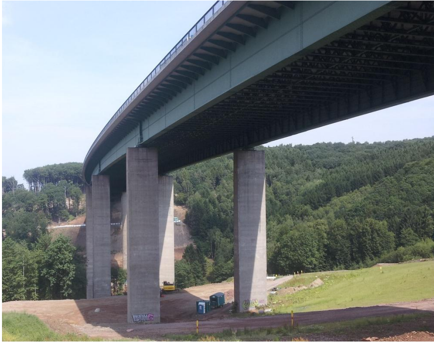
Obrázek 10 - Foto stávajícího mostu [76]
