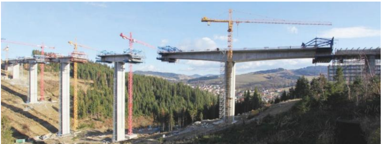
Obrázek 16 - Letmá betonáž mostu [59]
