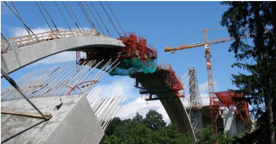
Obrázek 24 - Most přes Opárenské údolí - vyvěšování oblouku [66]
