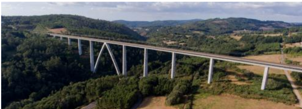
Obrázek 21 - Deza River Viaduct (Španělsko) [79]
