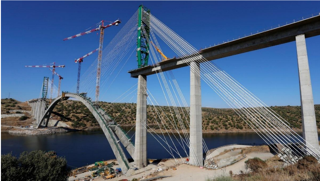
Obrázek 26 - Almonte River viaduct - vyvěšování oblouku [53]
