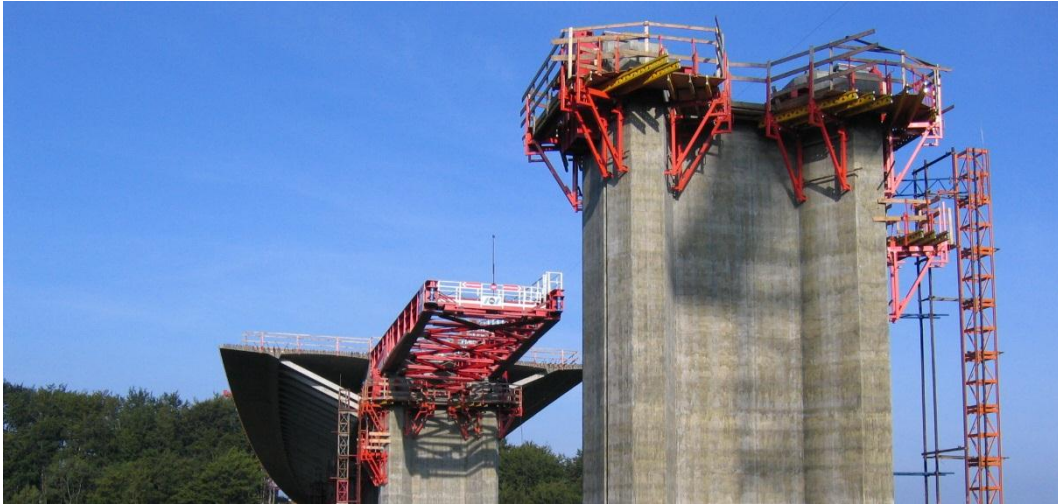
Obrázek 18 - Výsuv mostu (pohled na nos a boční vedení na pilíři) [85]
