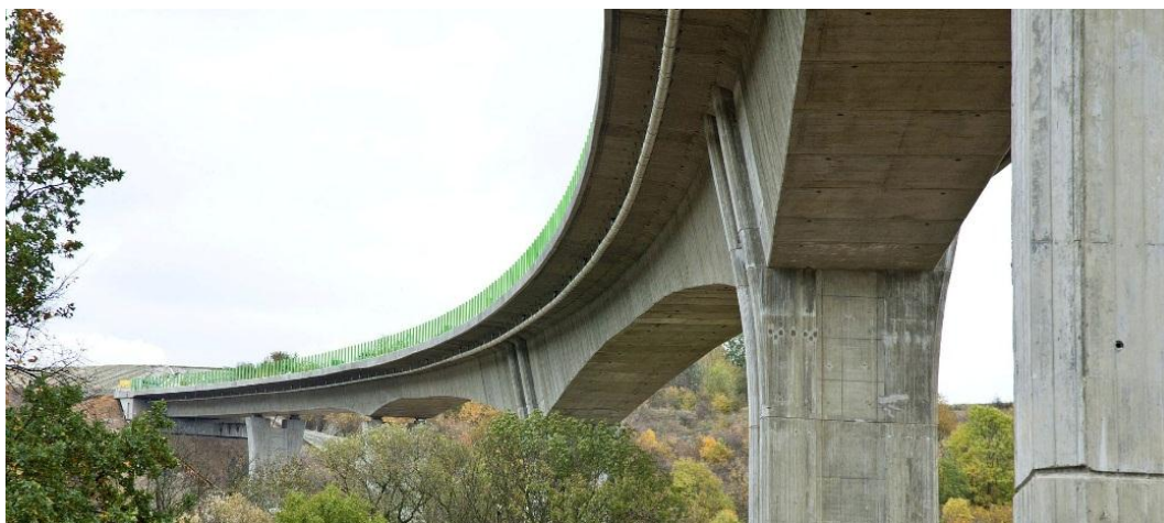
Obrázek 13 - Most přes údolí Chomutovky (Velemyšleves) [62]
