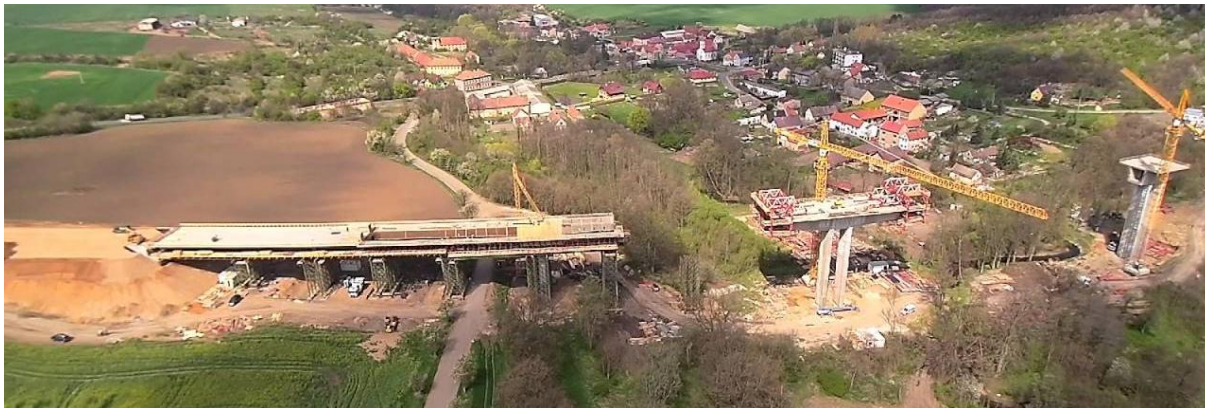
Obrázek 14 - Výstavba mostu I/27 Veľký Štárek [74]
