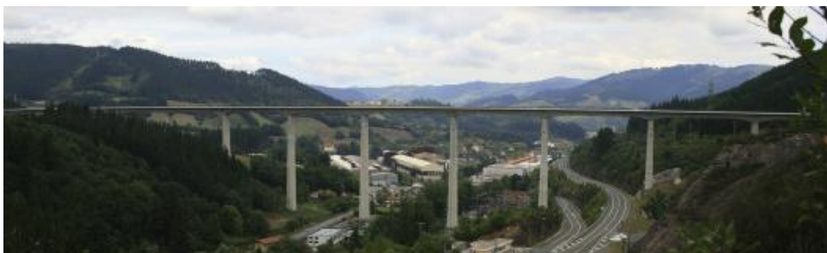
Obrázek 28 - River Deba viaduct - finální konstrukce [83]
