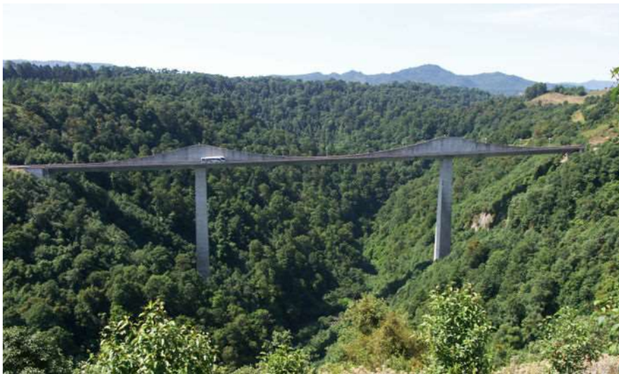
Obrázek 15: Barton Creek Bridge (USA) [14]
