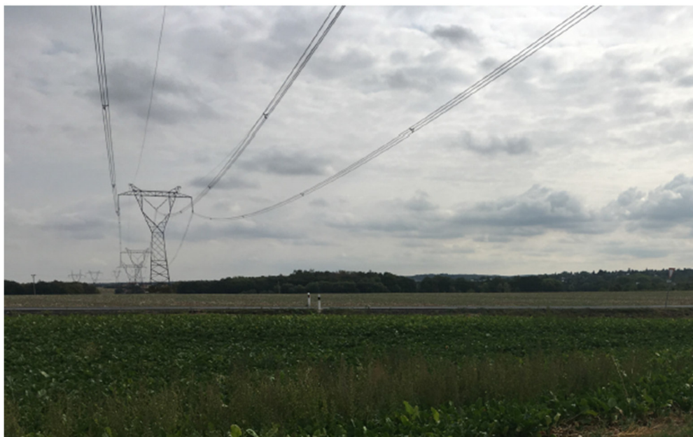
Obr. 4 Pohled na vedení VVN 400 kV, kterému se vyhýbá hlavní trasa
