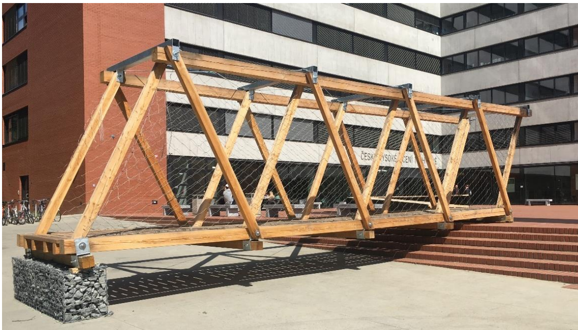
Obrázek 9.1 Pohled na lávku
