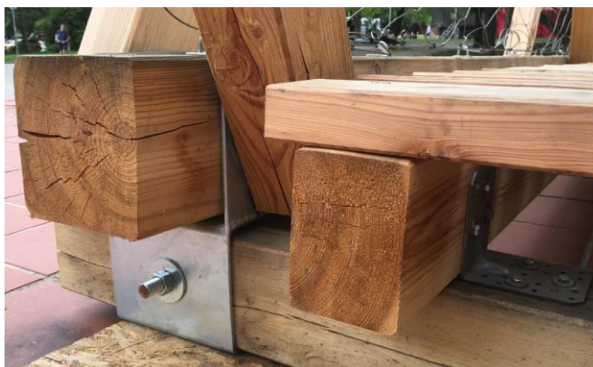
Obrázek 9.10 Připojení příčného trámu k podélným
