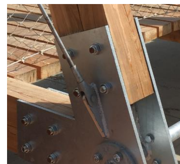
Obrázek 7.4 Připojení ocelového táhla
