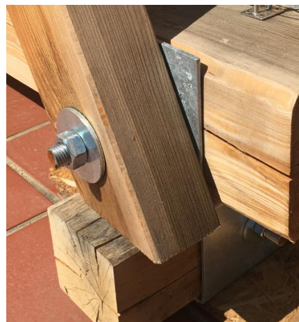
Obrázek 9.11 Připojení šikmého trámu k podélnému nosníku
