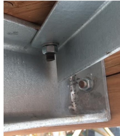
Obrázek 7.13 Připojení ztužidla
