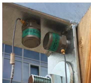
Obrázek 9.4 Připevnění snímačů na konstrukci
