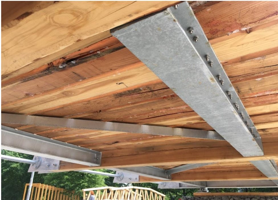
Obrázek 5.4 Spodní pohled na lávku
