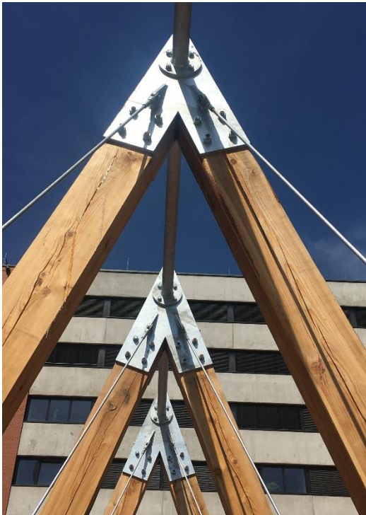
Obrázek 5.3 Pohled na vrcholové hlavice
