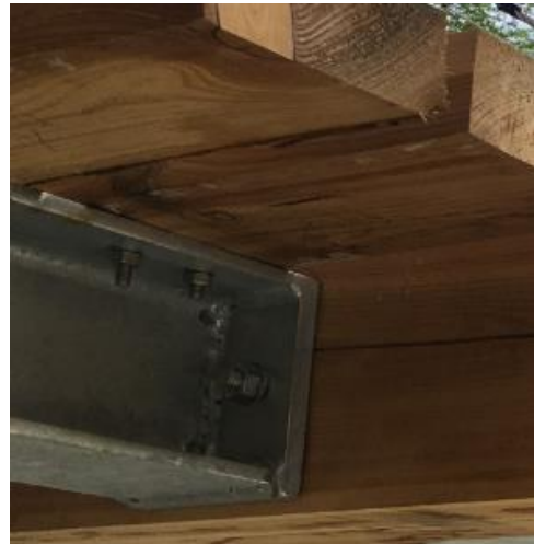
Obrázek 7.3 Připojení podélného nosníku na příčný dřevěný nosník
