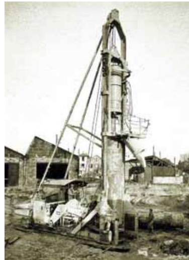
Obrázek 26: Nárazová drapáková souprava Benoto EDF s hydraulicky zatlačovanými pažnicemi, Francie v roce 1940 [6]
