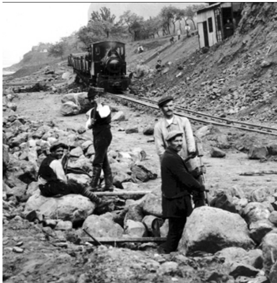
Obrázek 13: Rozrušování balvanů pomocí sochoru a palice na stavbě Masarykova zdymadla pod Střekovem v roce 1923 [13]
