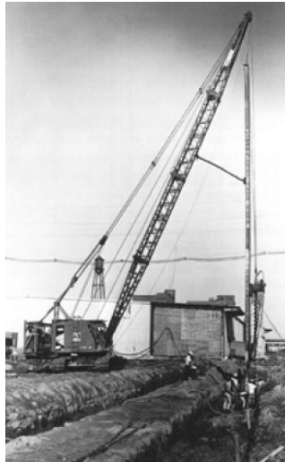
Obrázek 33: Jedna z prvních provádění pilot ACIP v USA, rok 1950 [7]
