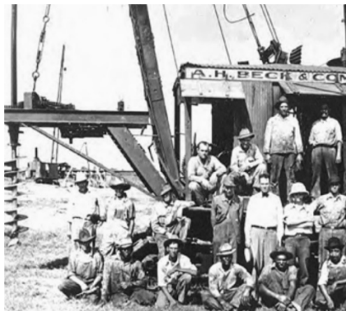
Obrázek 28: Jedna z prvních vrtných souprav pro vrtání pilot s nástavbou na parním bagrjeřábu v USA ve třicátých letech 20. století [6]
