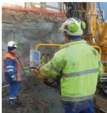
Obrázek 23: Počítačová kontrola procesu vrtání zařízením firmy Partner při vrtání kotev [5]
