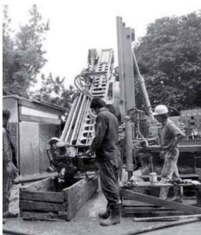
Obrázek 12: Vrtné práce na trase metra A pražského metra v roce 1974 [3]
