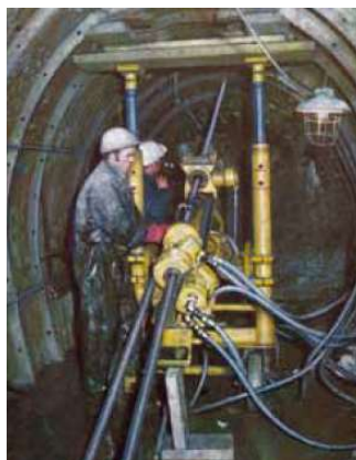
Obrázek 24: Vrtání plně hydraulickou vysokootáčivou jádrovací soupravou Diamec 250 pro sanaci nadloží před ražbou traťového tunelu metra I. A v Praze [5]
