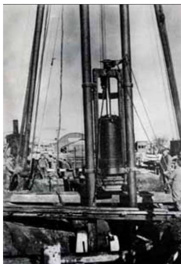
Obrázek 3: Beranění pilot parním beranem ještě v Nizozemsku v roce 1970 [2]
