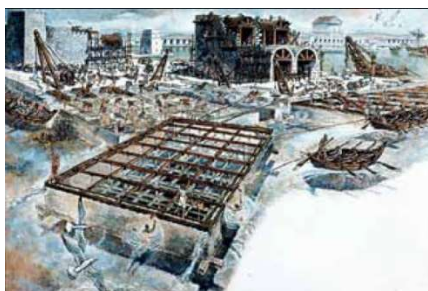
Obrázek 36: Znárodnění výstavby středomořského přístavu Ceaserea v Judei v roce 20 př. n. l. s naplavováním skříňového základu na určené místo [8]
