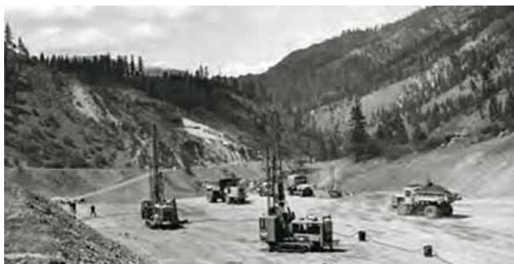
Obrázek 21: První samohybné vrtací lomařské soupravy Quarrymaster firmy Ingersoll-Rand z roku 1948 v USA [5]
