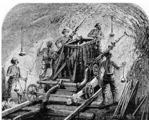
Obrázek 14: Vrtací vůz s prvními pneumatickými kladivy, zavedený na stavbě tunelu Fréjus v roce 1861[4]
