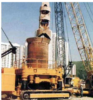
Obrázek 27: Zapažovací rotátor RDM-M 3000 pro pažnice o průměru 3 m do hloubek 85 m [6]
