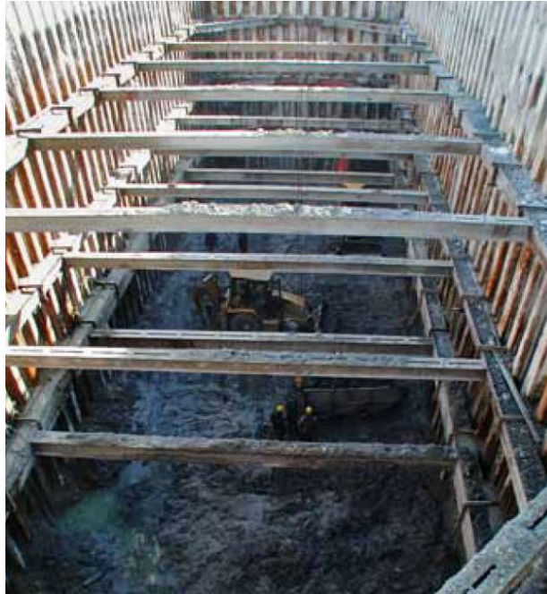
Obrázek 42: Rozpíraná štětová štětová jímka na Dunaji těsněná ve dně tryskovou injektáží [9]
