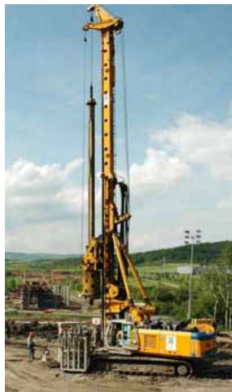
Obrázek 29: Pilotovací souprava Bauer BG 25 s lafetou nesenou paralelogramem a s posuvnou vrtnou hlavou, zavrtávající výpažnici v roce 2003 [6]
