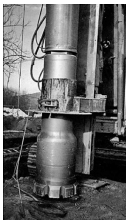
Obrázek 32: Vrtání pilot o průměru 900 mm ponorným kladivem Sandvik XL24 na soupravě Soilmec R12 a s třemi kompresory Atlas-Copco v amfiblech s křemennými žílami na stavbě Omya [7]
