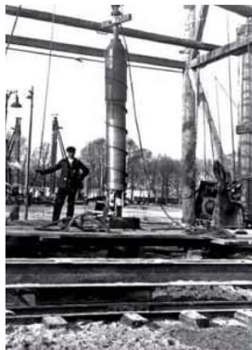
Obrázek 8: První ponorný vibrátor z roku 1937 na stavbě [2]
