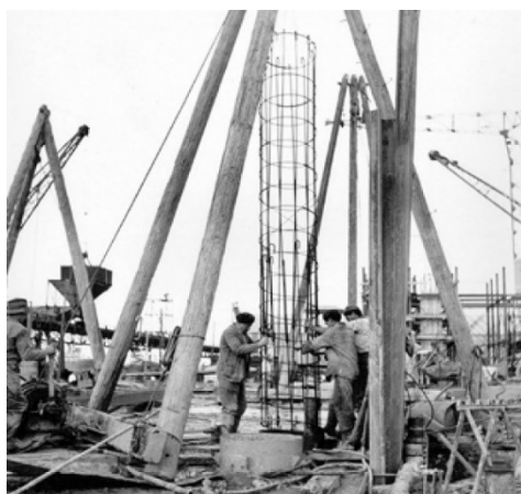
Obrázek 25: Stavba s vrtáním pilot několika soupravami trojnožek klasickým nárazovým způsobem pomocí lanového vrátku, jimž byly osazeny armokoše ve Francii 1950 [6]
