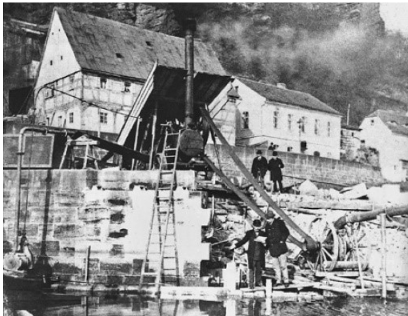
Obrázek 40: Obvyklé uspořádání čerpání z jímky pro nábrežní zeď [13]
