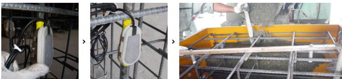
Obr. 25: Proces instalace štítku se senzorem do železobetonové konstrukce [43]
