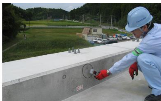
Obr. 21: Kontrola krycí vrstvy pomocí RFID technologie [39]
