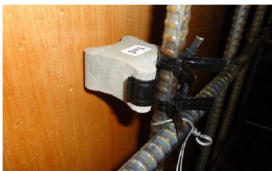
Obr. 20: Umístění distanční podložky do bednění nosné stěny [39]
