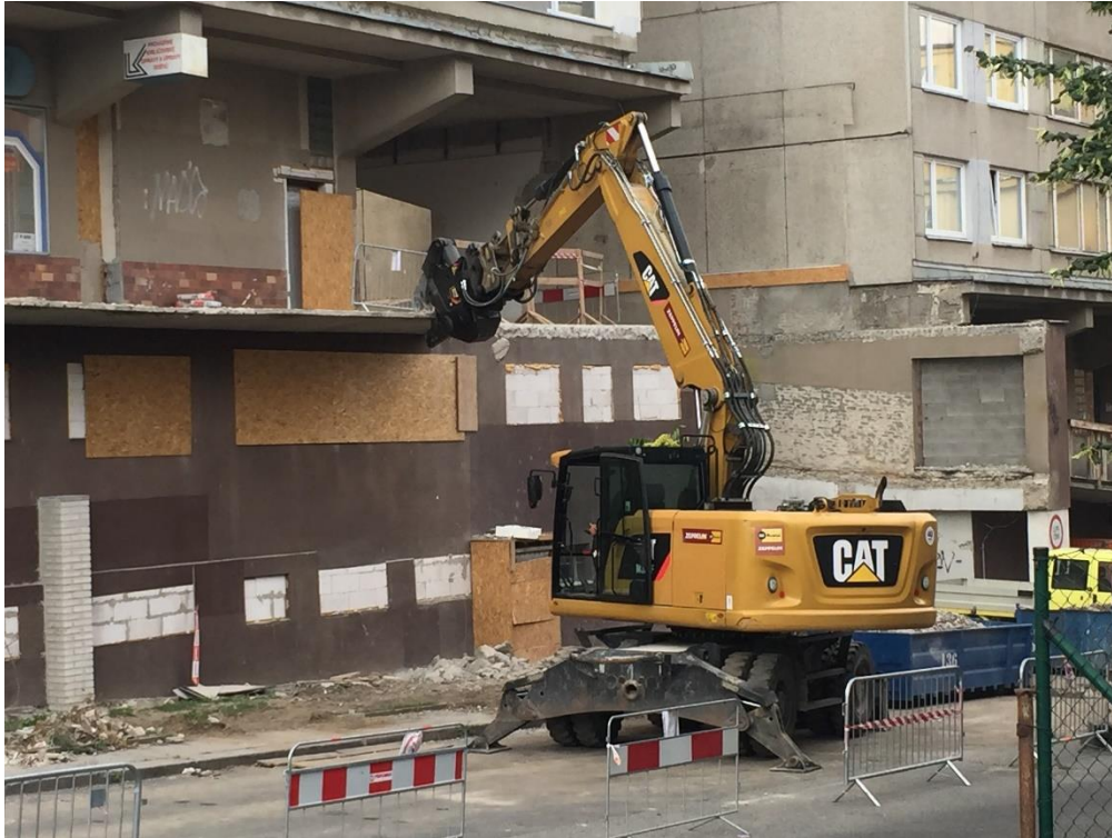
Obr3.: Kolové rypadlo s hydraulickými nůžkami pro bourací práce [3]
