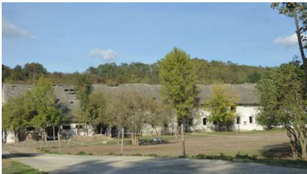
Obr. 42: Opuštěný zemědělský objekt č. 5 v obci 1.2 Nehasice – okolí spásáno [archiv autora]
