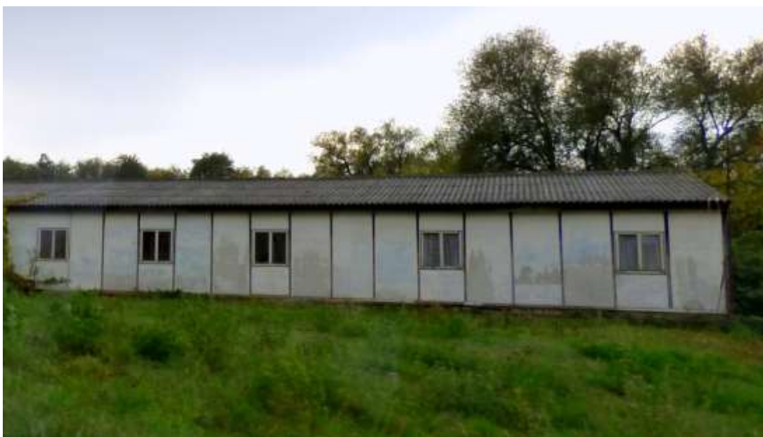
Obr. 18: Montovaný objekt zemědělské ubytovny v obci Tuchořice (objekt č. 34) – střešní krytina z vlnitých azbestocementových desek, obklad svislých konstrukcí z desek shodného materiálu [archiv autora]
