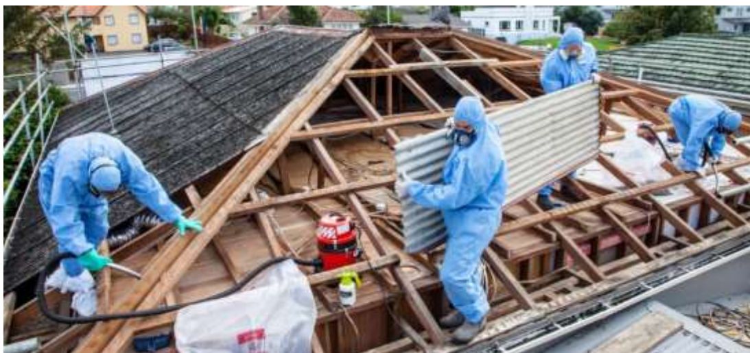
Obr. 26: Vzorový způsob demontáž azbestocementových vlnitých desek – Nový Zéland [97]
