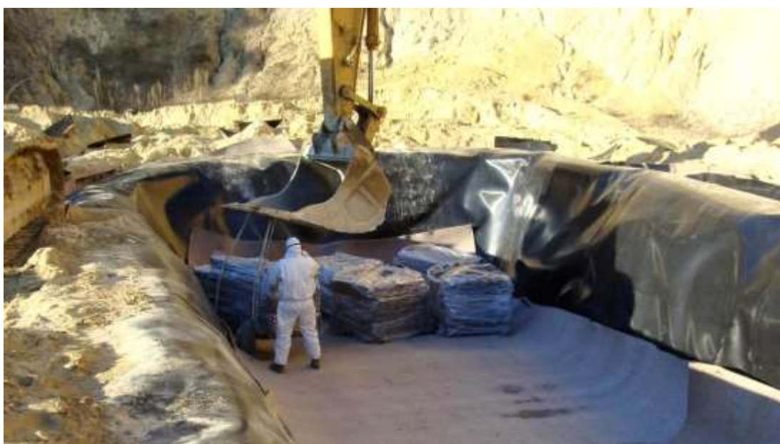
Obr. 32: Ukládání azbestocementového odpadu do připraveného sektoru skládky - Makedonie [99]
