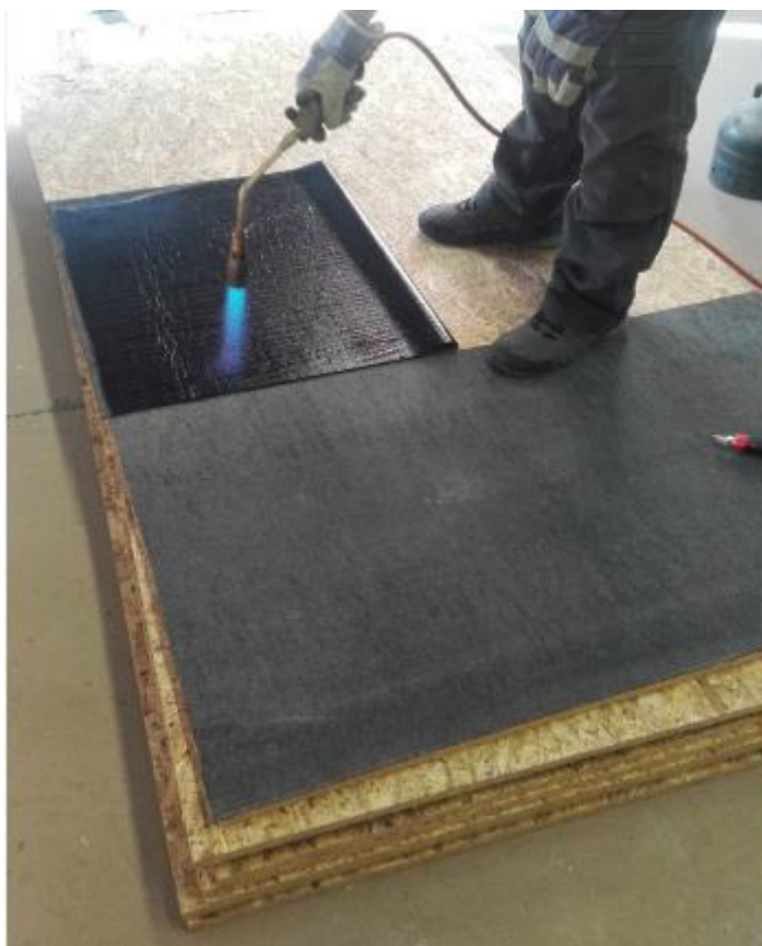
Obr. 14: Lepení samolepicích asfaltových pásů
