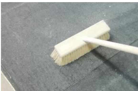
Obr. 19: Odstranění volného minerálního posypu z asfaltových pásů
