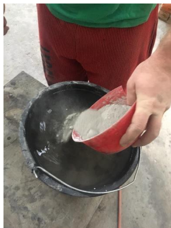
Obrázek 25 - Přidávání přísady Krystol Mix pro záměs KRYS 1
