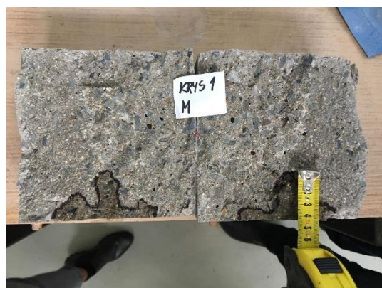
Obrázek 48 - Průsak tlakovou vodou KRYSI-mráz
