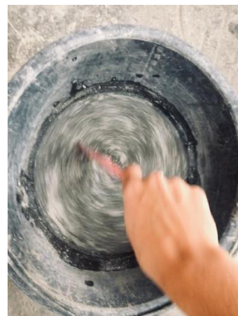
Obrázek 26 - Michání řídké směsi záměsové vody s přísadou Xypex Admix C – 1000NF pro záměs XYP 2
