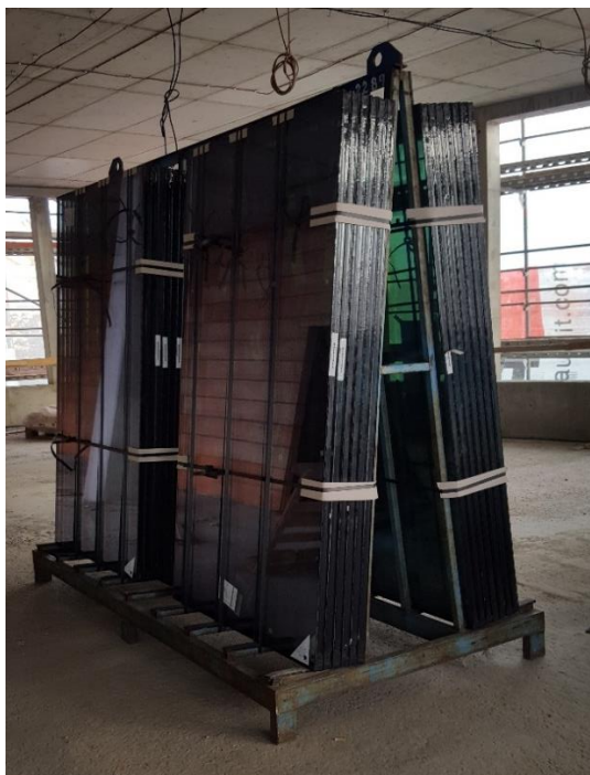
Obr. 6: Způsob skladování skla (vlastní zdroj)
