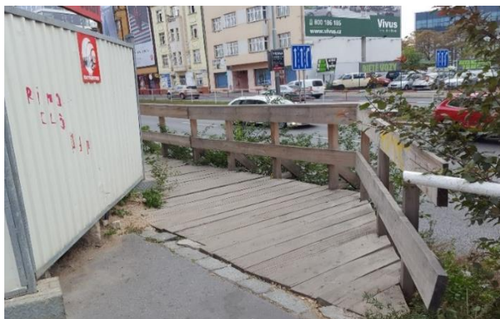
Obr. 14: Provizorní lávka pro pěší (vlastní zdroj)
