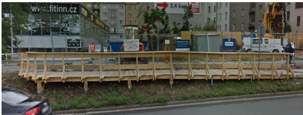
Obr. 15: Pohled na provizorní lávku z komunikace Argentinská [7]
