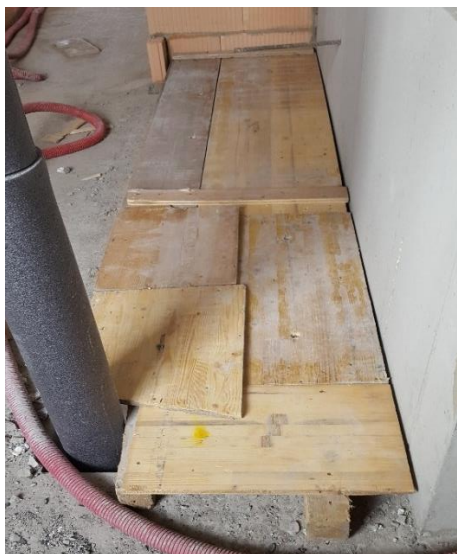
Obr. 20: Zakrytí otvorů (vlastní zdroj)
