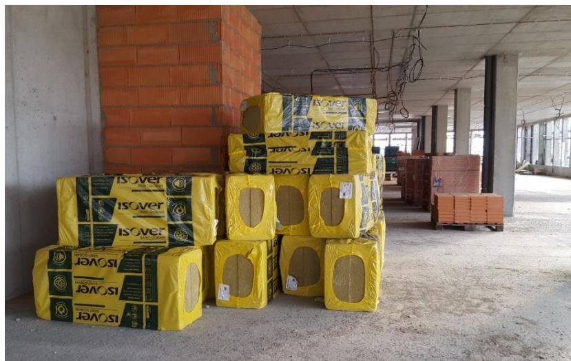
Obr. 5: Skladování tepelné izolace a cihelných bloků (vlastní zdroj)
