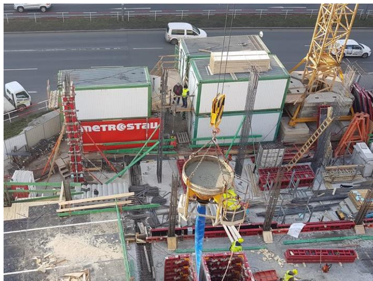
Obr. 8: Zařízení staveniště (vlastní zdroj)
