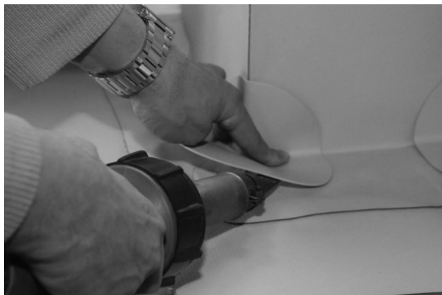
Obrázek 34: Vyztužení rohů a koutů
