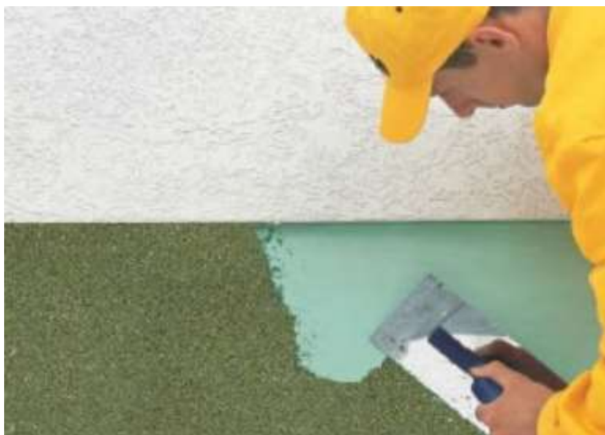
Obrázek 43: Nanášení finální omítky soklu
