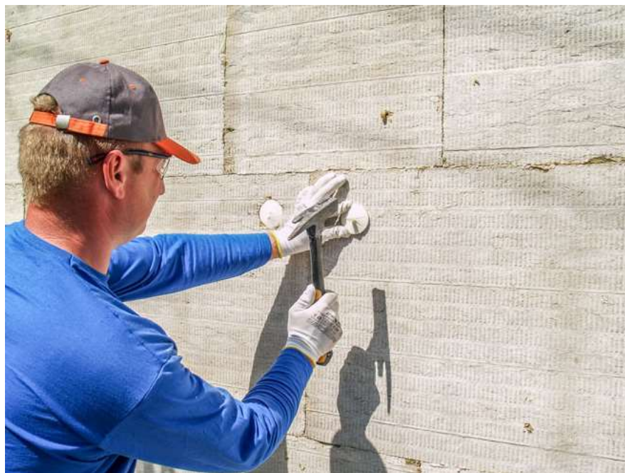
Obrázek 40: Kotvení tepelné izolace
