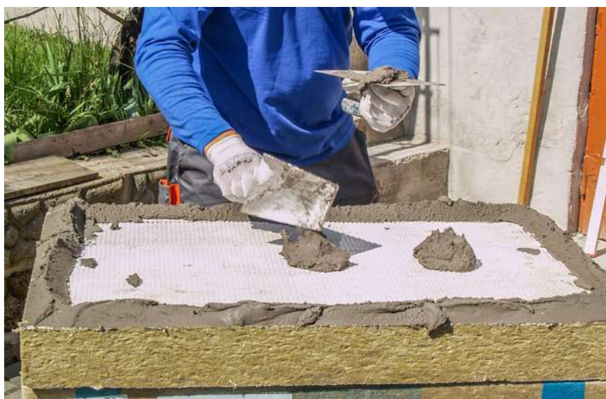
Obrázek 39: Nanášení lepidla na izolaci
