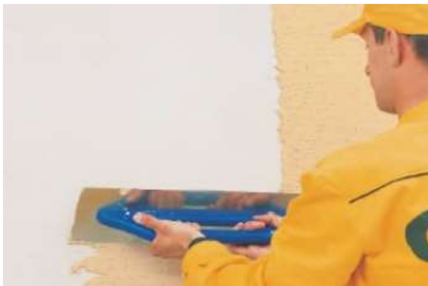
Obrázek 42: Nanášení finální omítky
