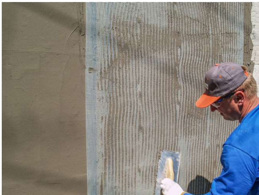
Obrázek 41: Nanášení základní vrstvy
