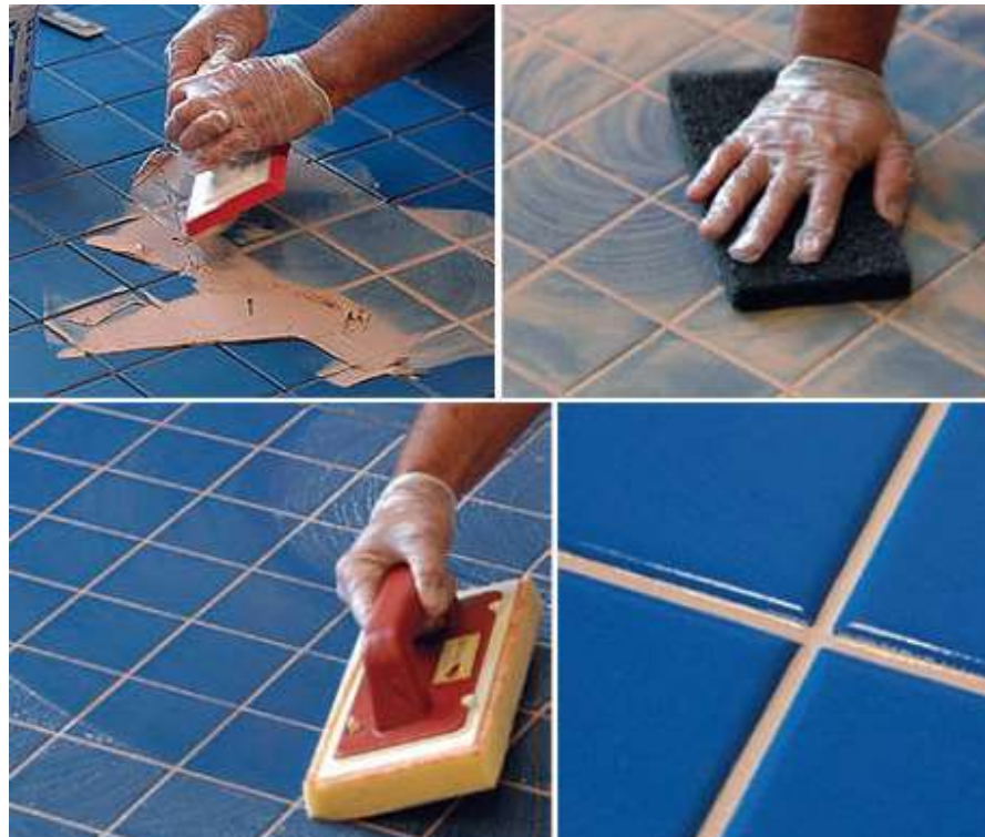
Obrázek 38: Spárování
