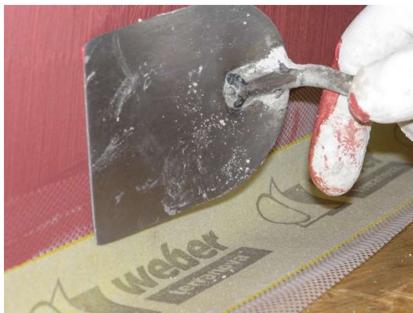
Obrázek 36: Hydroizolační stěrka
