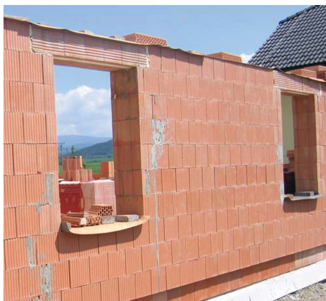
Příklady použití překladů Porotherm KP 7 u broušených cihel Porotherm T Profi plněných minerální vatou
