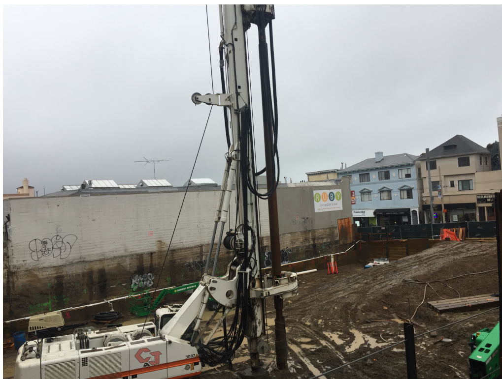
Obr. 8: Vrtná soustava – vliv počasí na stavenišť. Zdroj: Autor práce
