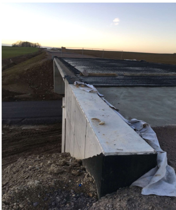
Obrázek 10 – Nezajištěná hran pádu – most
