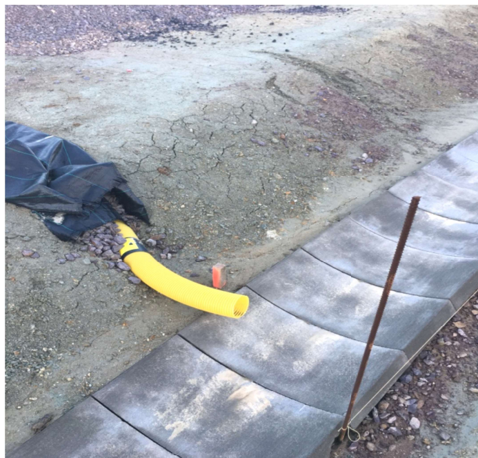
Obrázek 1 – Nebezpečí napíchnutí zaměstnance
