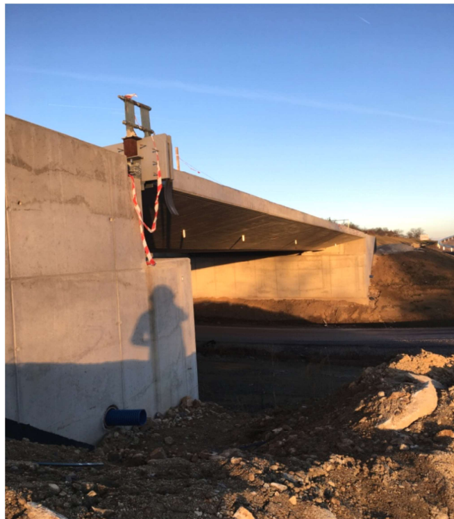
Obrázek 5 – Nezajištěná hrana pádu
