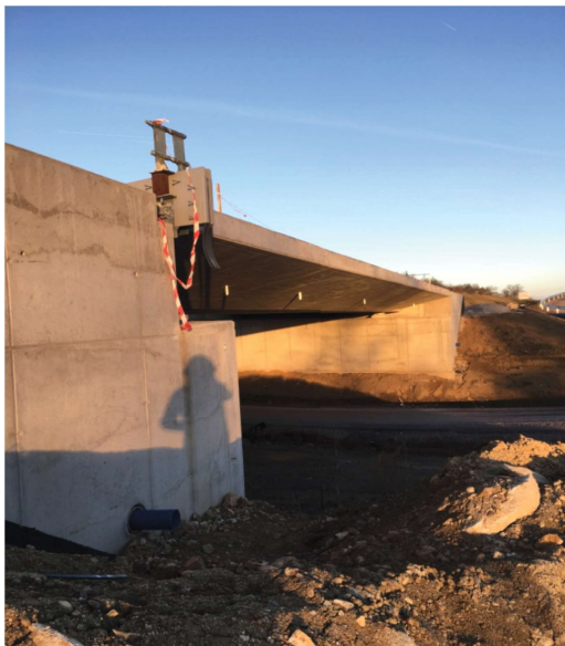
Obr. 49: Ukázka lešení trámového mostu
