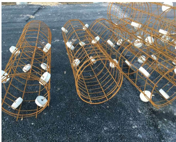
Obr. 61: Chybějící podložky
