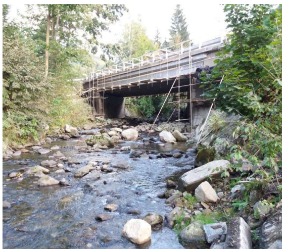
Obr. 45: Ukázka lešení trémového mostu
