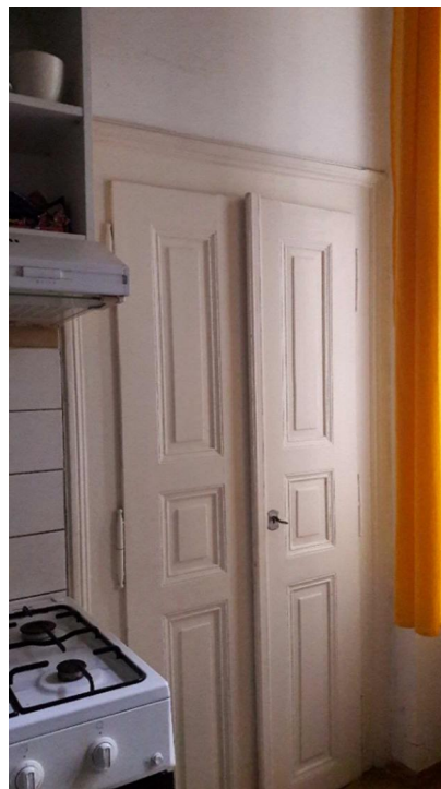
Obr. 64: Místnost 3.01 – dveře do komory
