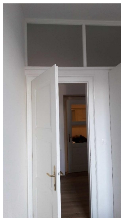
Obr. 120: Místnost 6.04 – pohled od okna
