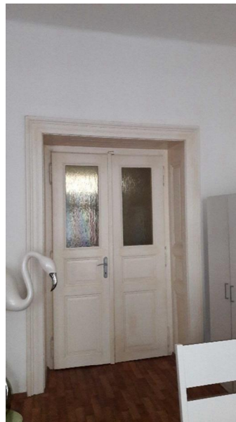
Obr. 69: Místnost 3.04 – pohled od okna
