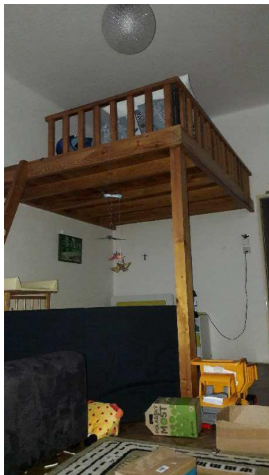
Obr. 34: Místnost 2.01 – dřevěná konstrukce postele
