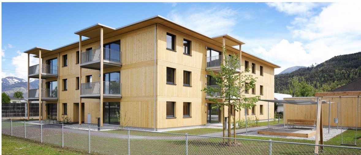
Obr. 4: Bytový dům Heldenstraße, Feldkirch – Rakousko [8]
