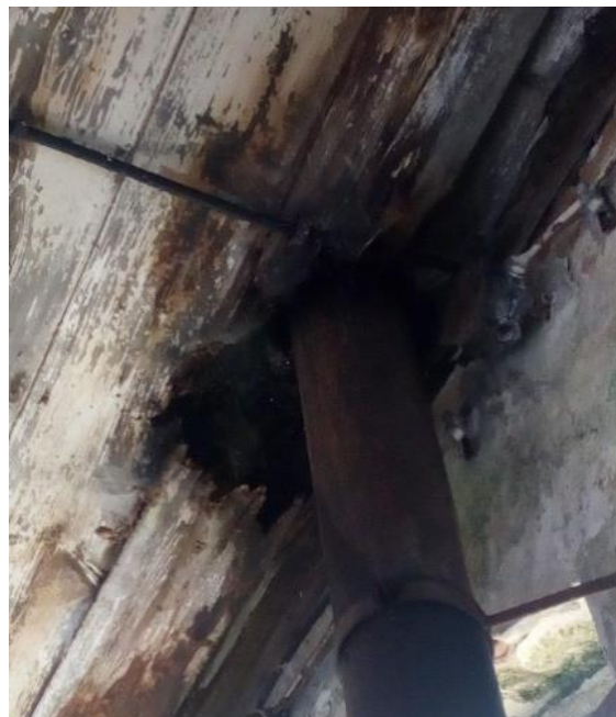
Obrázek č. 19 Pohled na střechu přístavku z interiéru [vlastní zdroj]
