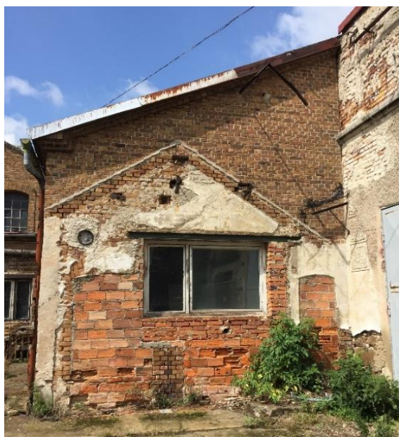
Obrázek č. 9 Vyplnění chybějícího zdiva cihlami různých typů a formátů [vlastní zdroj]
