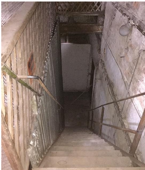
Obrázek č. 26 Dřevěné schodiště propojující jednotlivá podlaží haly „C“ [vlastní zdroj]
