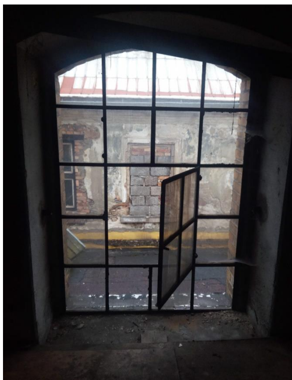
Obrázek č. 69 Detail členěného okna [vlastní zdroj]
