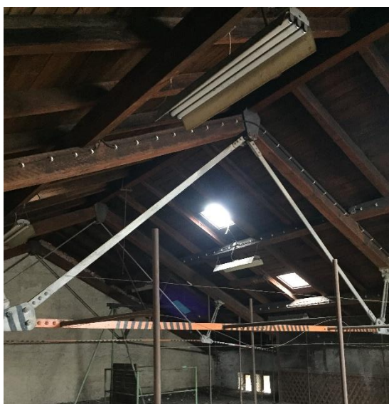
Obrázek č. 22 Krov dvoupodlažní části haly „C“ [vlastní zdroj]
