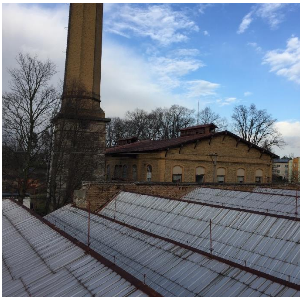
Obrázek č. 68 Pohled na halu s pilovou střechou a zbytek areálu [vlastní zdroj]
