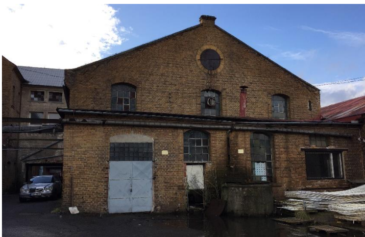
Obrázek č. 74 Východní pohled na přístavek a halu „C“ [vlastní zdroj]
