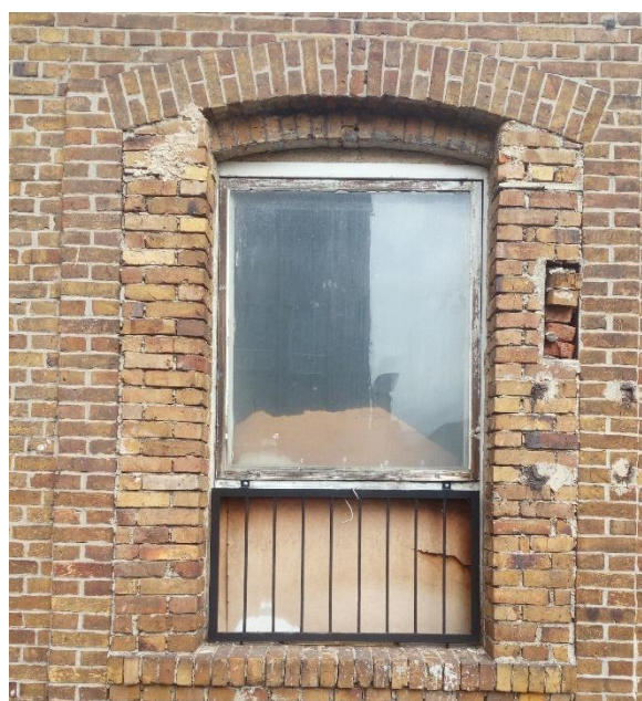
Obrázek č. 23 Detail okna s jednoduchým zasklením [vlastní zdroj]
