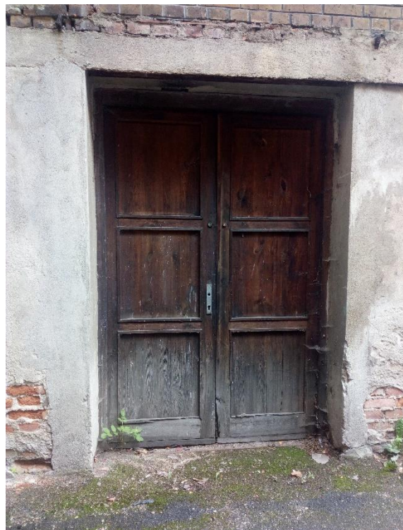
Obrázek č. 71 Pohled na dřevěné dveře [vlastní zdroj]
