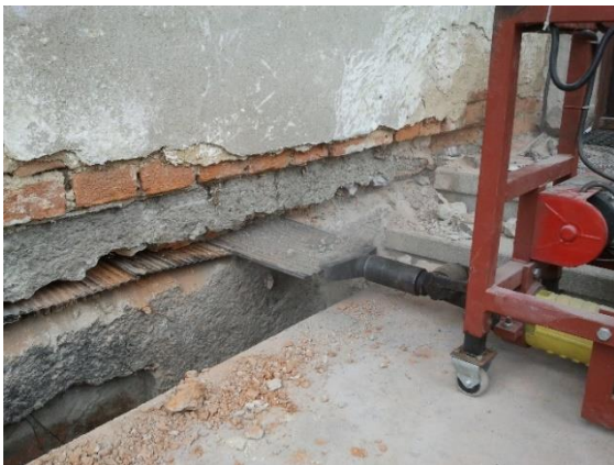
Obrázek č. 52 Metoda pneumatického zarážení plechů [14]
