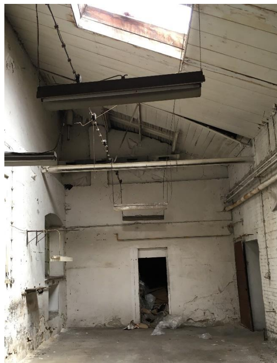
Obrázek č. 70 Pohled do interiéru bývalého skladu [vlastní zdroj]
