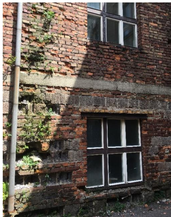
Obrázek č. 10 Zazdění chybějícího zdiva škvárobetonovými tvárnicemi, rostlinné porosty ve spárách zdiva [vlastní zdroj]
