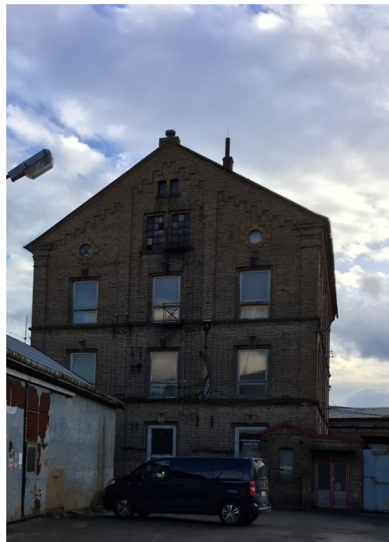
Obrázek č. 63 Vjezd do areálu [vlastní zdroj]
