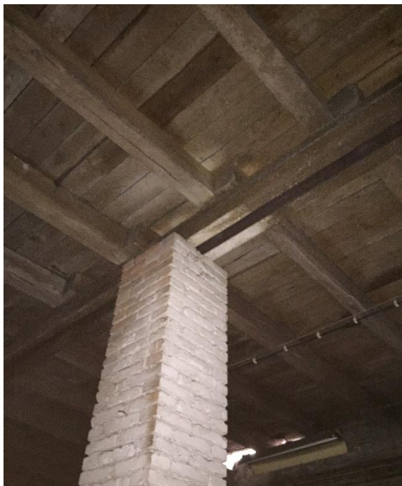
Obrázek č. 13 Zděný sloup a pohled na strop haly „C“ [vlastní zdroj]
