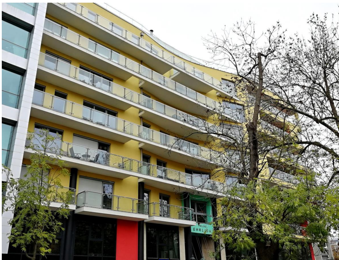
Obr. 10: Západní fasáda bytového domu Šafaříkovy sady. Plzeň. Zdroj: autor
