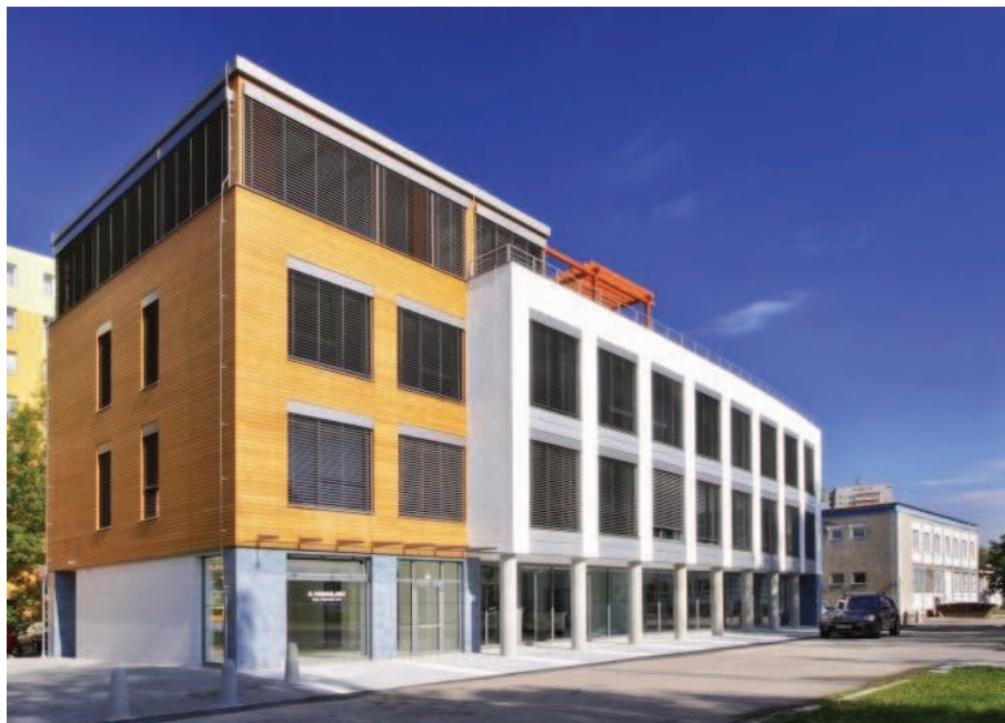
obr. 5 – Žaluzie – administrativní budova Havířov, zdroj [14]
