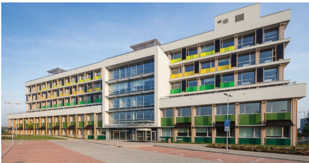
obr. 1 – Pevná clona v kombinaci s fotovoltaickými panely – Fakulta životního prostředí, Česká zemědělská univerzita – Praha Suchdol, zdroj [10]
