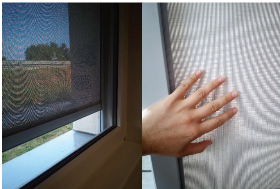
obr. 8 – Detail screenových rolet – TYMO Soběslav (foceno 31.8.2018)
