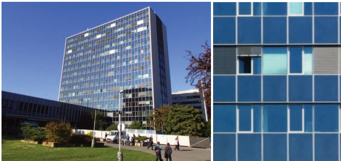
obr. 16 – Jihozápadní fasáda budovy A Fakulty stavební ČVUT v Praze a charakteristický výsek obvodového pláště, zdroj [21] a [22]
