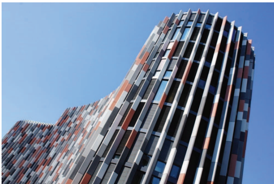
obr. 3 – Vertikální stínící stěny (a žaluzie) – VIG administrativní budova – Praha Karlín, zdroj [12]
