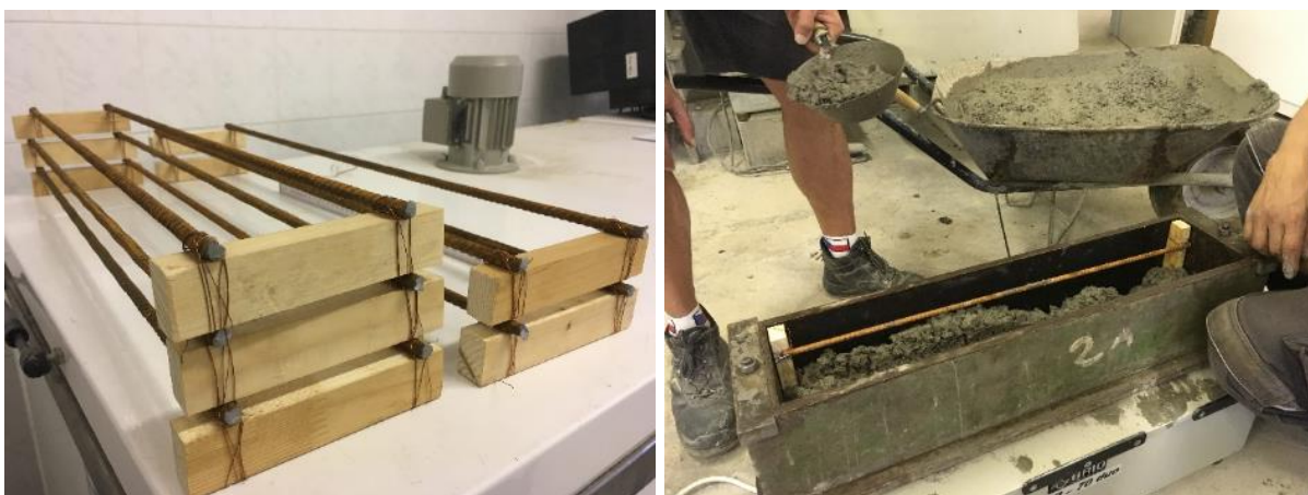
Obr. 22, 23: Vlevo výztuž připravená na uložení do formy, vpravo ukládání betonu do formy ležící na deskovém vibrátoru
