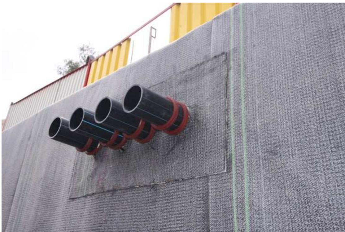
Obr. 27: Foto č.18 - Prostup na svislé ploše na záporové pažení (autor DP)
