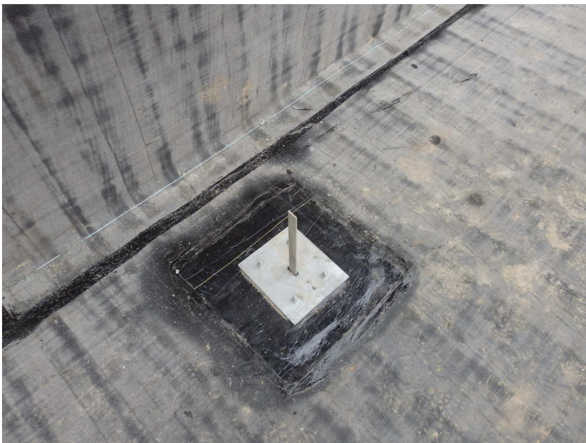
Obr. 32: Foto č.23 - Opracování prostup na vodorovné ploše - zemnicí pásek (autor DP)
