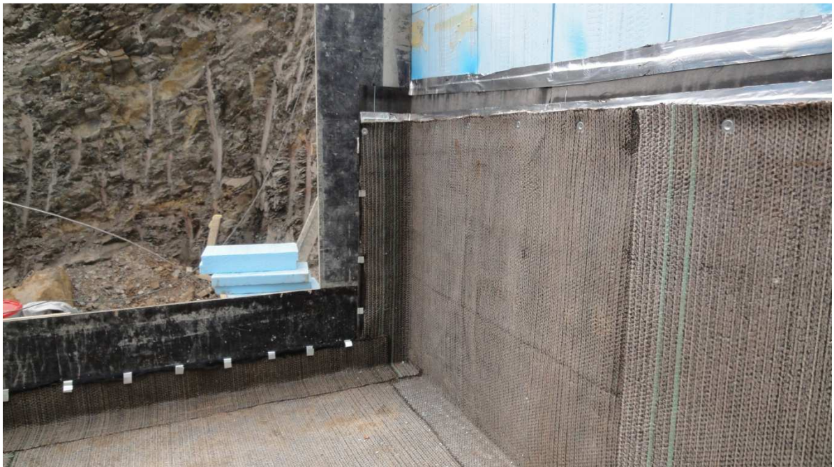
Obr. 18: Foto č.9 - Přechod z otevřené stavební jámy na záporové pažení (autor DP)
