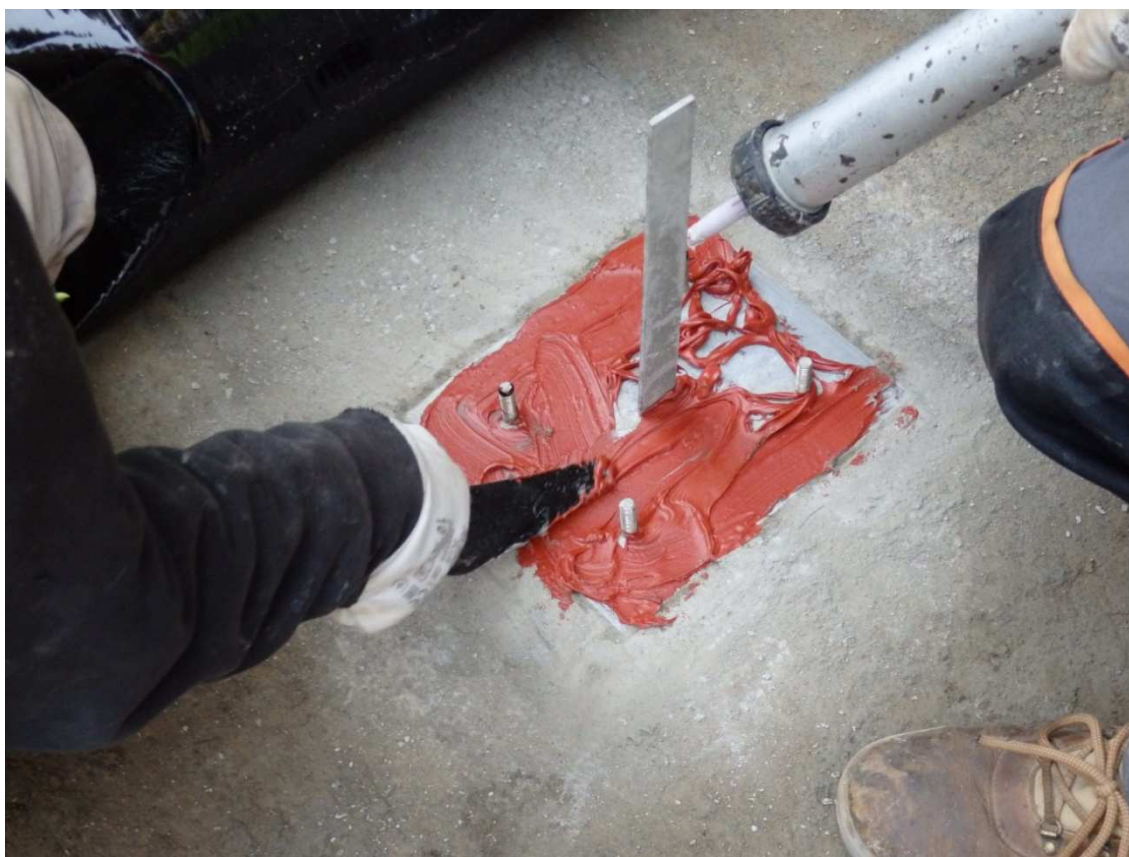
Obr. 31: Foto č.22 - Opracování prostupu na vodorovné ploše - zemnicí pásek (autor DP)
