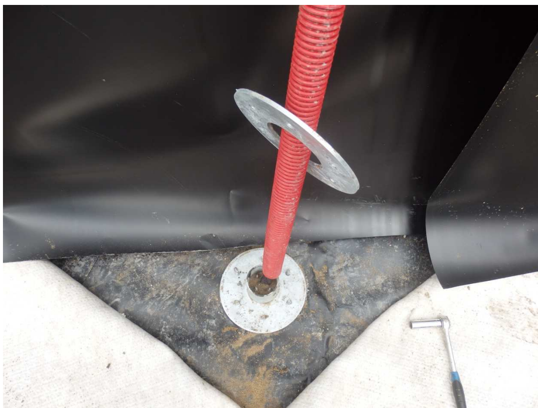
Obr. 30: Foto č.21 - Opracování prostup na vodorovné ploše - pevná volná příruba (autor DP)
