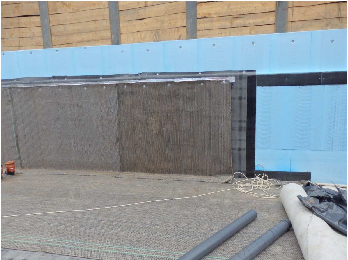
Obr. 17: Foto č.8 - Přechod vodorovné izolace na svislou na záporového pažení (autor DP)
