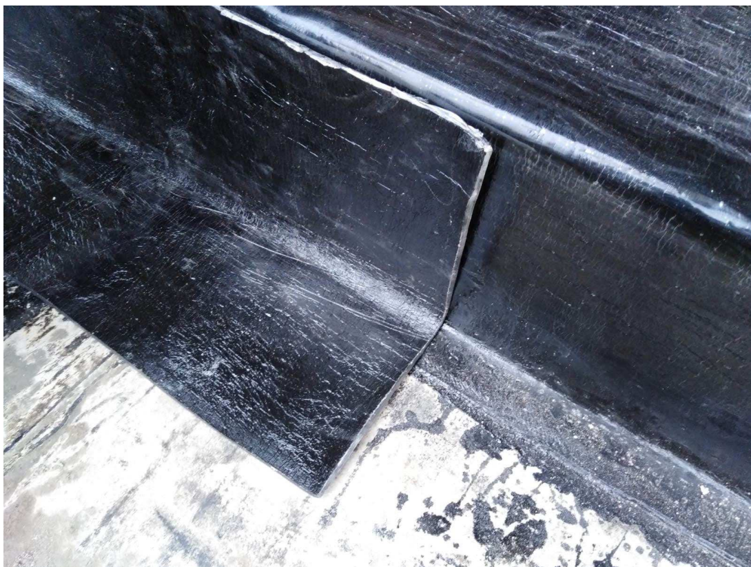
Obr. 10: Foto č.1 - zesilující asphaltový pás pro provedení zpětného spoje (autor DP)
