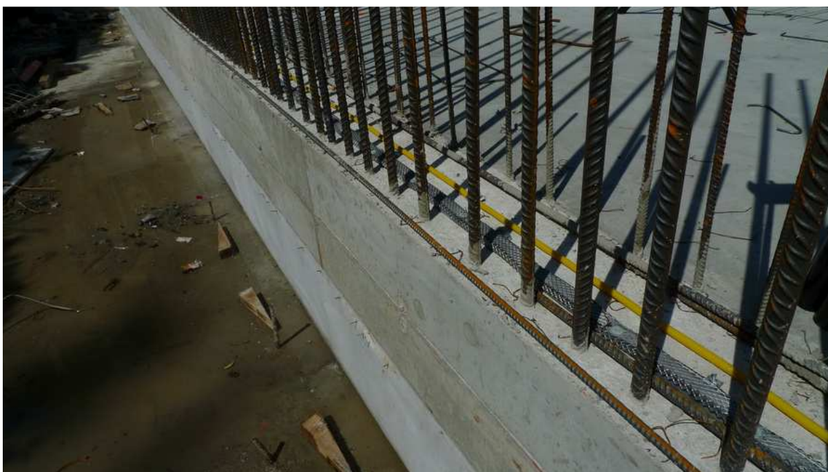
Obr. 14: Foto č.5 - izolační systém po odbednění (autor DP)
