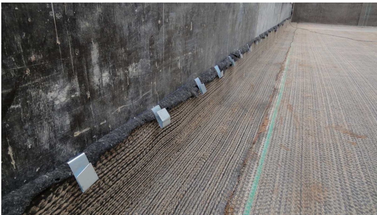
Obr. 13: Foto č.4 - Izolační systém připraven pro realizaci základové ŽB desky (autor DP)
