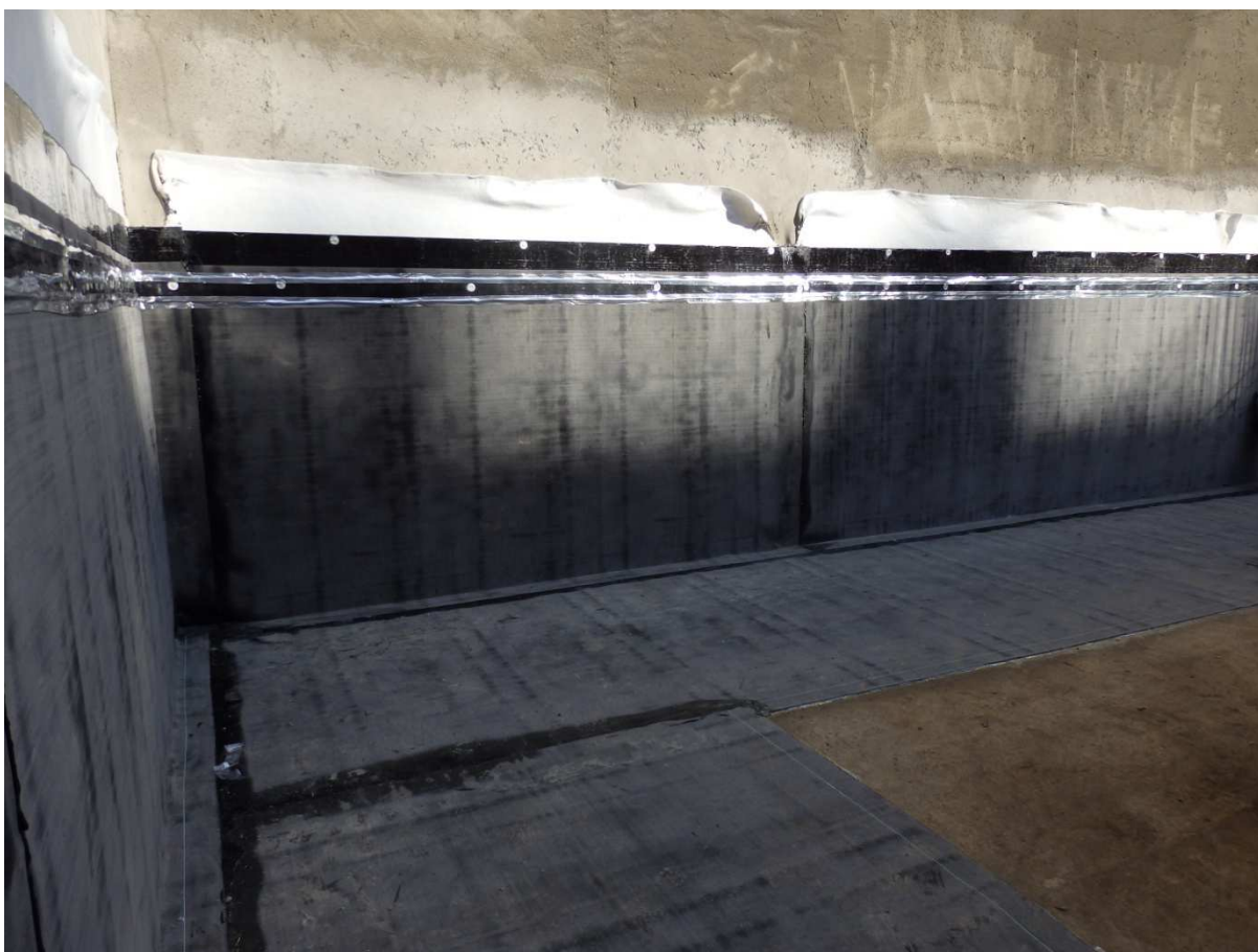
Obr. 19: Foto č.10 - Etapové ukončení izolace na pažení (autor DP)
