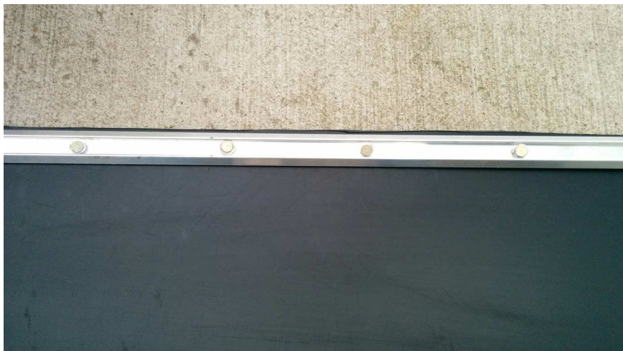
Obr. 41: Foto č.25 - Ukončení PVC-P fólie pozinkovanou lištou (autor DP)
