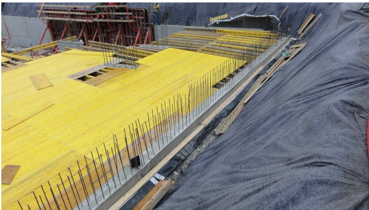
Obr. 20: Foto č.11 - Přejechod mezi záporovým pažením na ŽB stěnu (autor DP)
