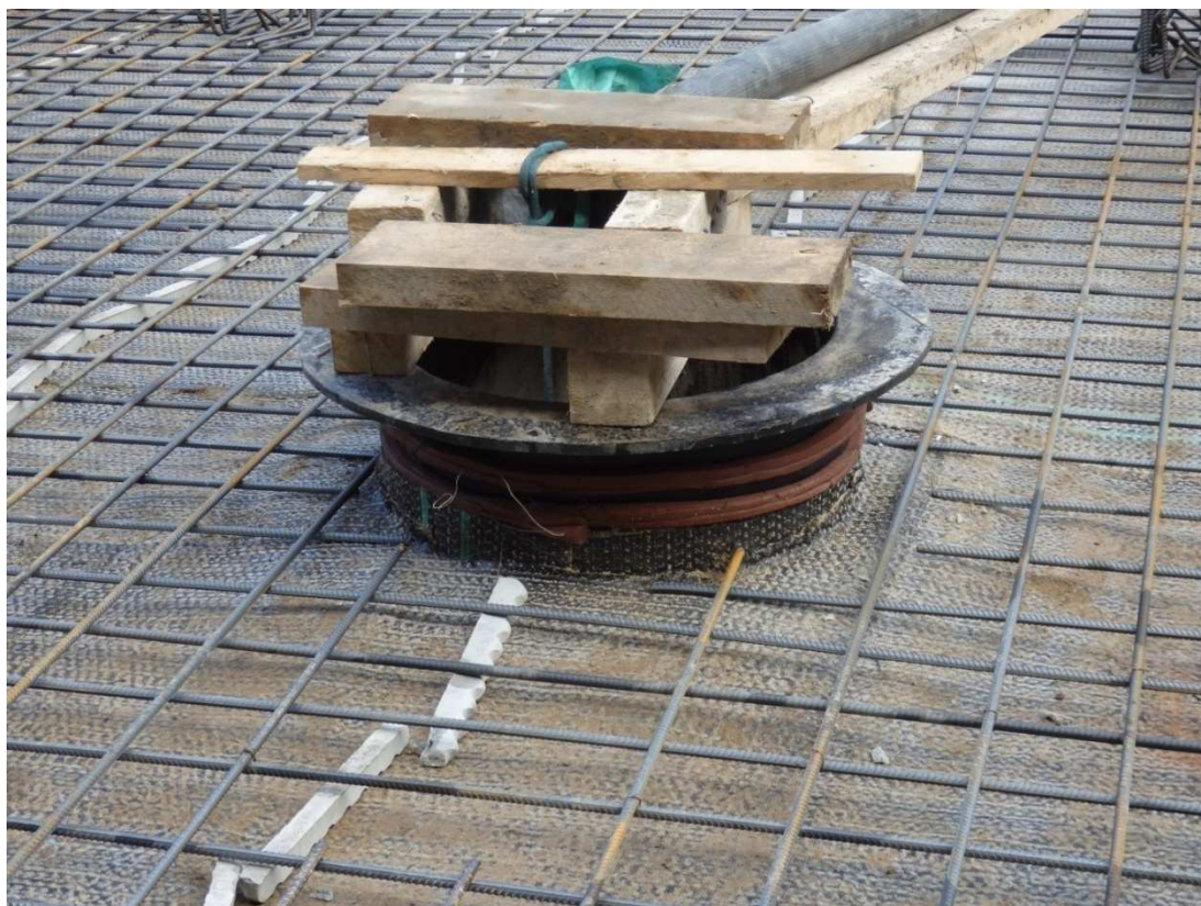
Obr. 29: Foto č.20 - Opracování prostup na vodorovné ploše - čerpací studna (autor DP)
