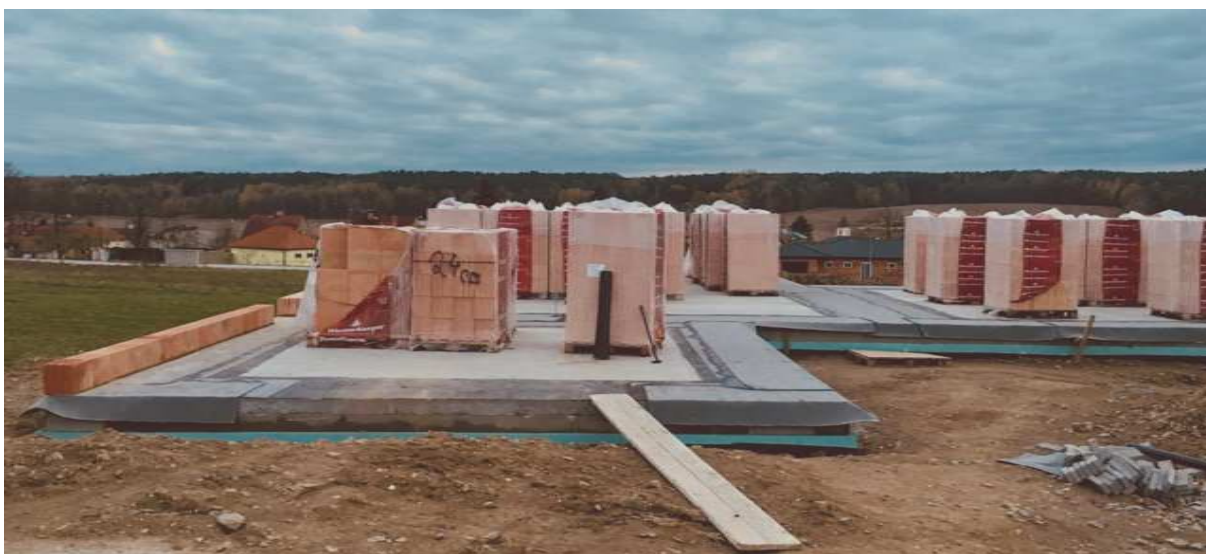
Obr. 40: Foto č.24 - Připravené pasy pod obvodové zdivo (autor DP)
