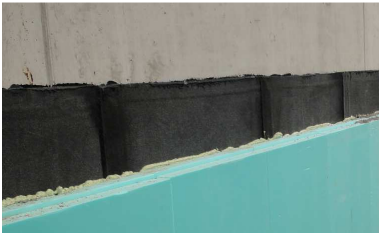
Obr. 43: Foto č.27 - Ukončení asfaltových pásů (autor DP)
