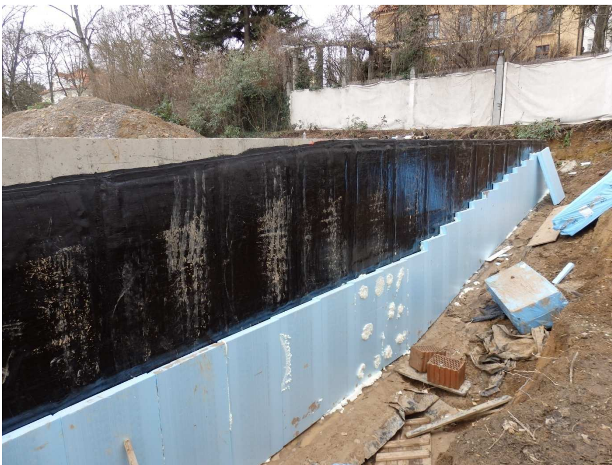
Obr. 21: Foto č.12 - Znečištěný zpětný spoj u přechodu z pažení na ŽB stěnu (autor DP)
