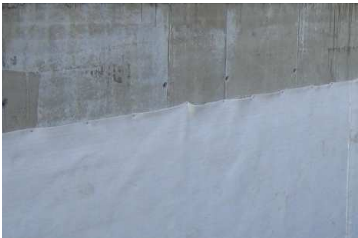
Obr. 44: Foto č.28 - Ukončení geotextílie bodovým kotvením (autor DP)
