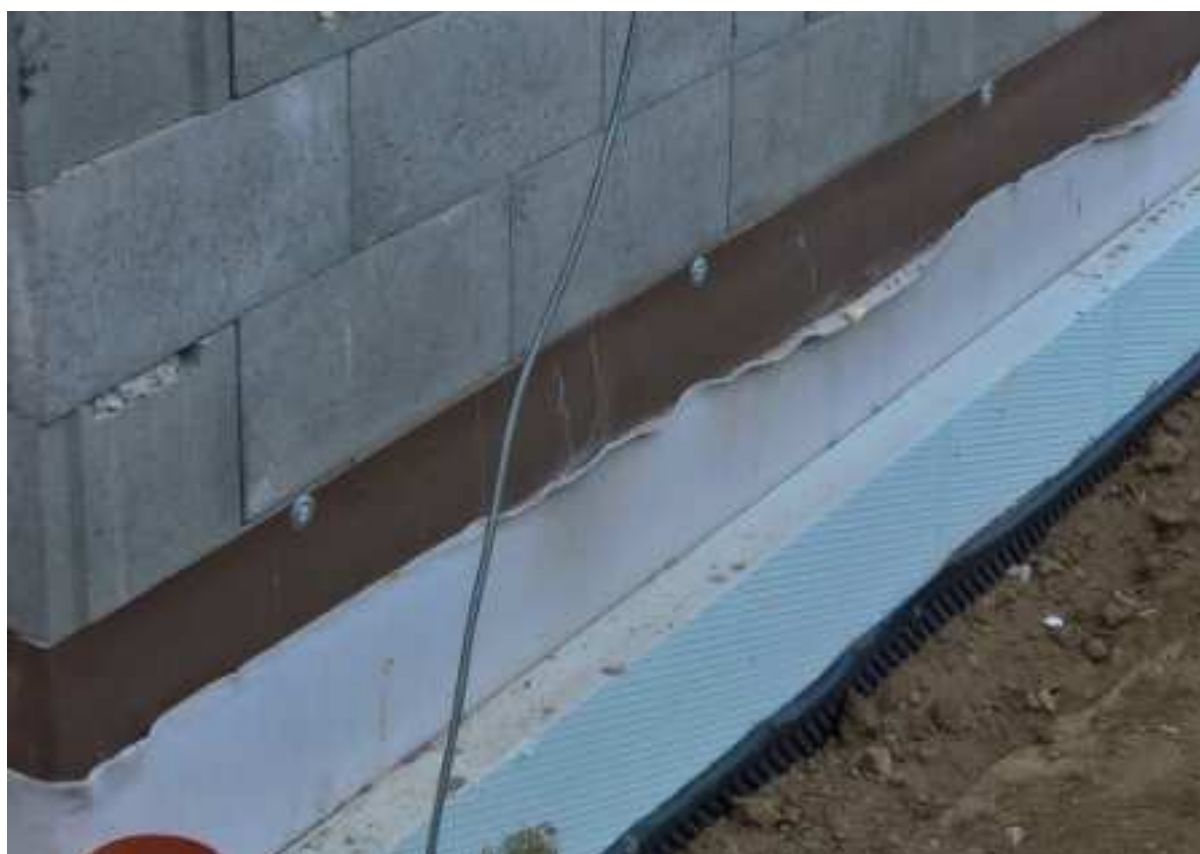
Obr. 42: Foto č.26 - Ukončení PVC-P fólie lepením + pojistné bodové kotvení (autor DP)
