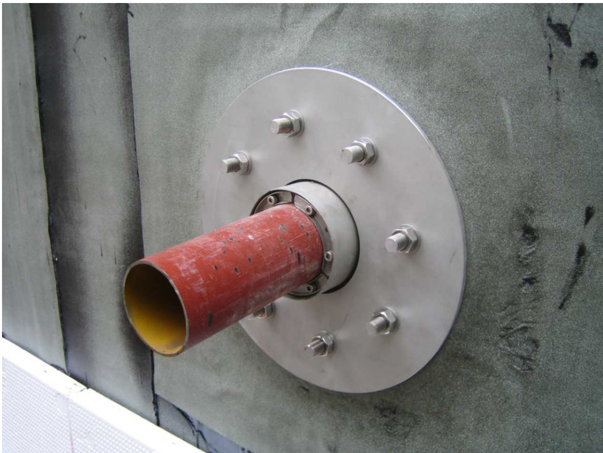
Obr. 24: Foto č.15 - Prostup na svislé ploše pevná volná příruba + potrubní těsnění (autor DP)
