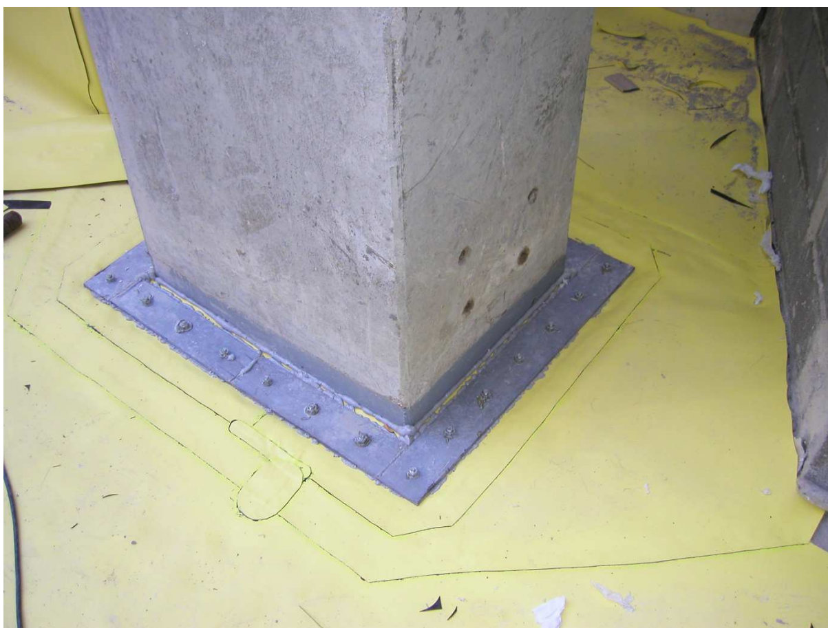
Obr. 15: Foto č.6 - PVC-P fólie se signální vrstvou, oprácvání sloupu kotevní pásnicí (autor DP)
