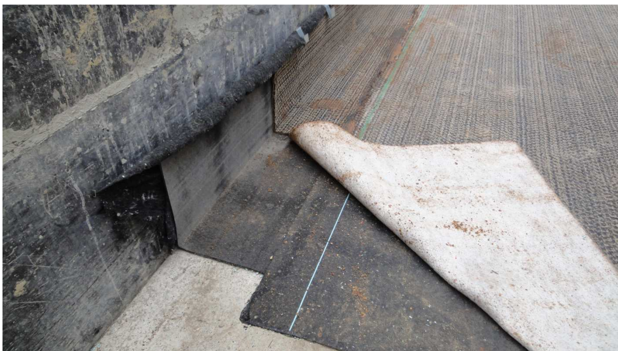
Obr. 12: Foto č.3 - ukončení izolačního systému na bednění (autor DP)
