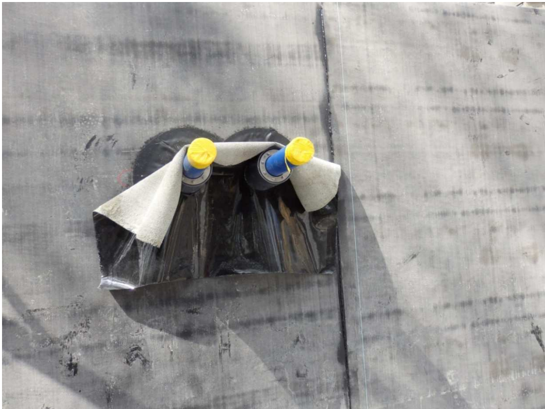
Obr. 25: Foto č.16 - Prostup na svislé ploše s těsněním a PEHD chráničkou (autor DP)
