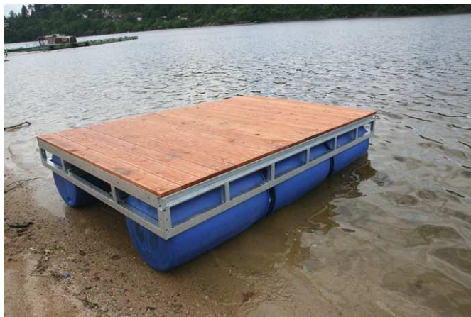
Obr. 26 Molo tvořené plováky z plastových barelů, které podporují pochozí konstrukci tvořenou z ocelové konstrukce a dřevěných prken – převzato z webu www.river-marina.cz [38]
