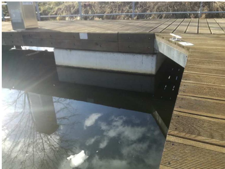
Obr. 44 Detail betonového plováku
