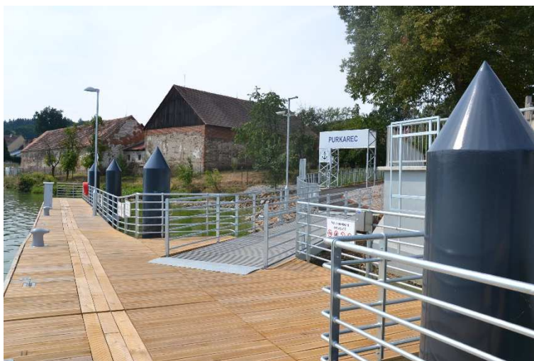
Obr. 41 Ocelová lávka spojující břeh s přístavištěm – převzato z webu www.penzionpurkarec.com
