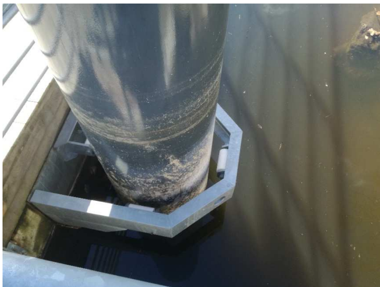
Obr. 39 Zadržná konstrukce pomocí ocelové objímky
