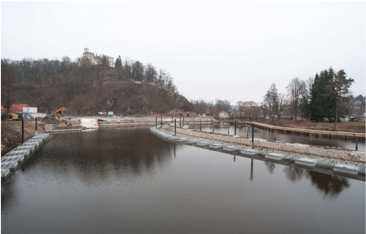
Obr. 43 Fotografie ze stavby přístaviště Hluboká nad Vltavou – převzato z webu www.pristavhluboka.com [27]
