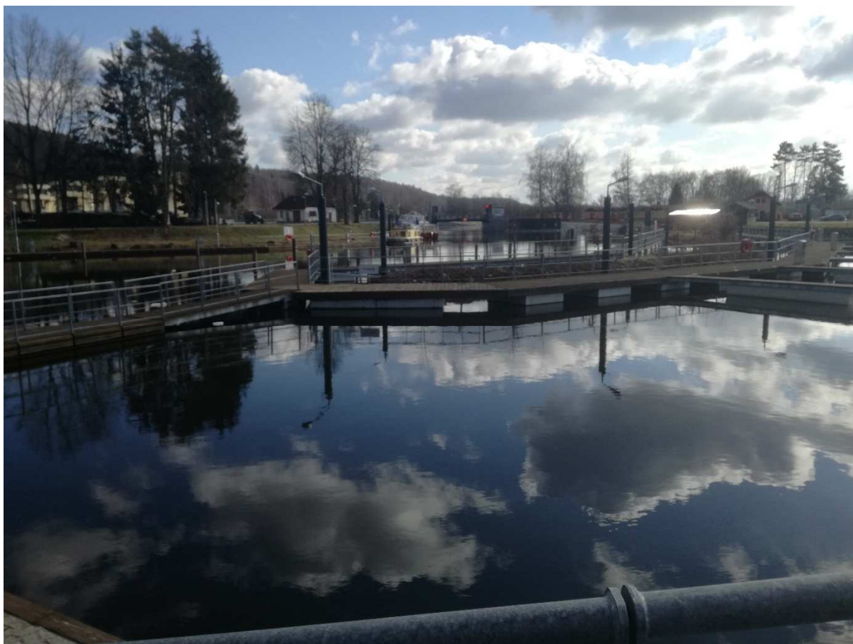
Obr. 32 Molo tvořené z betonových plováků a ocelové pochozí konstrukce v přístavu Hluboká nad Vltavou
