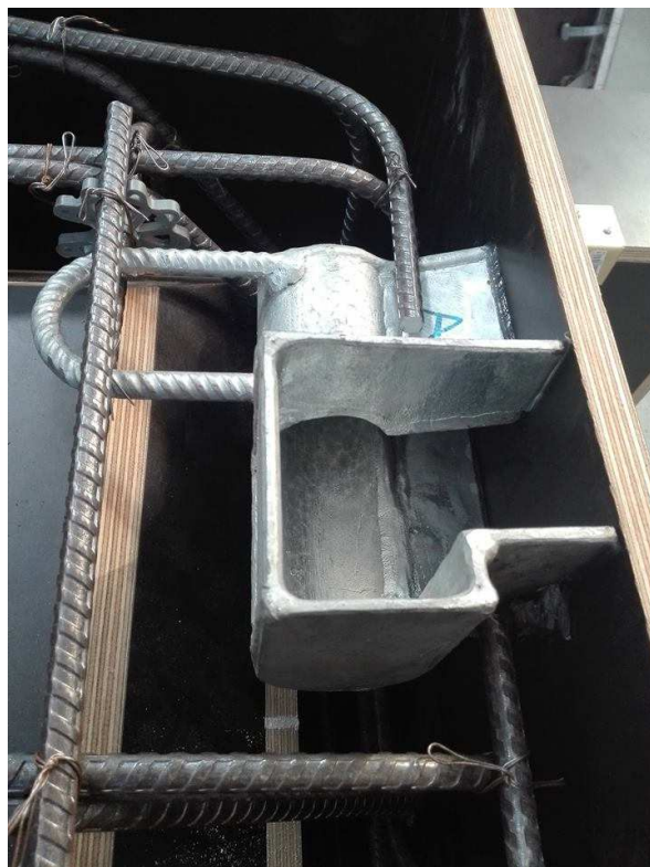
Obr. 82 Díl A – ocelové pouzdro zabetonované do stěn prvku
