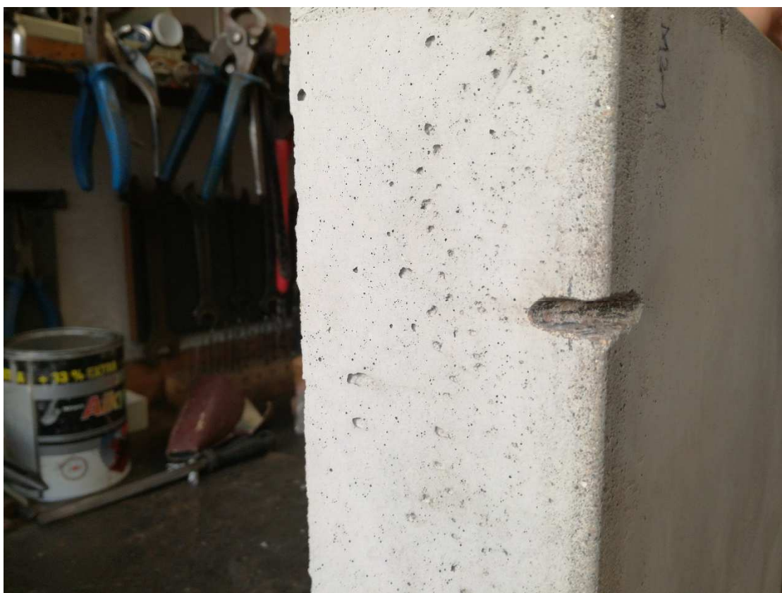
Obr. 119 Drážka ve zkušebním prvku vyřezaná pomocí úhlové brusky
