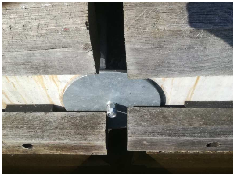
Obr. 38 Čelní deska kloubového spoje
