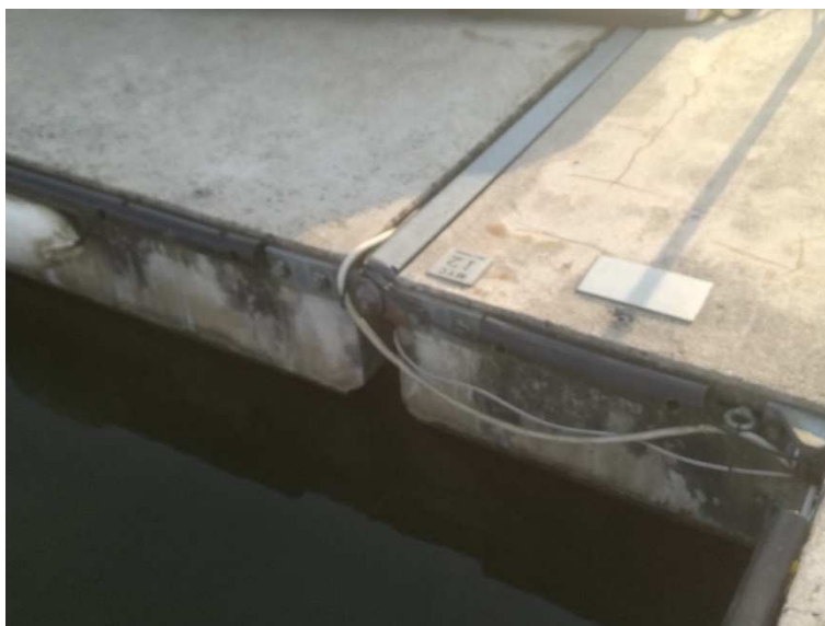
Obr. 49 Detail spojování betonových dílců
