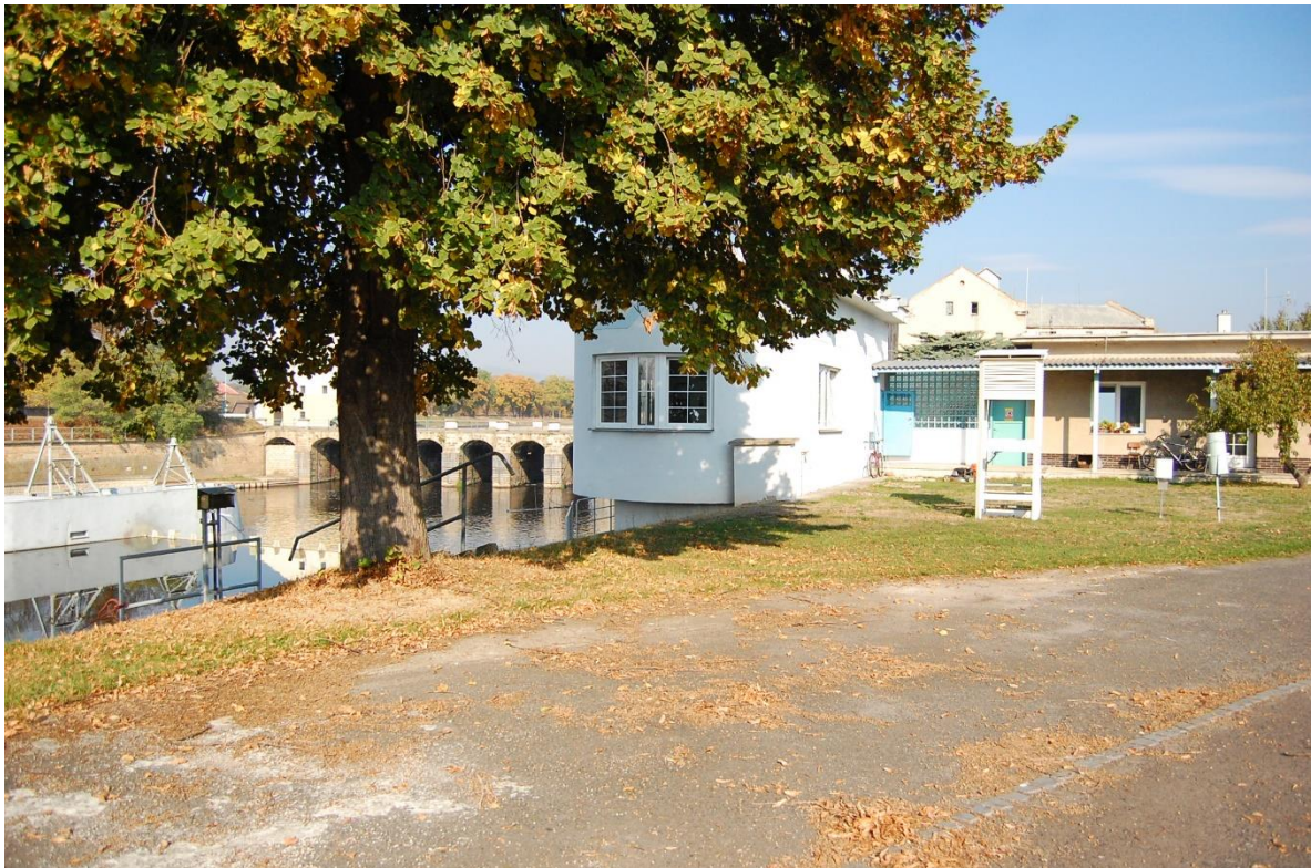
Obrázek 3 - Pohled na velín jezu - umístění MVE Terežín
