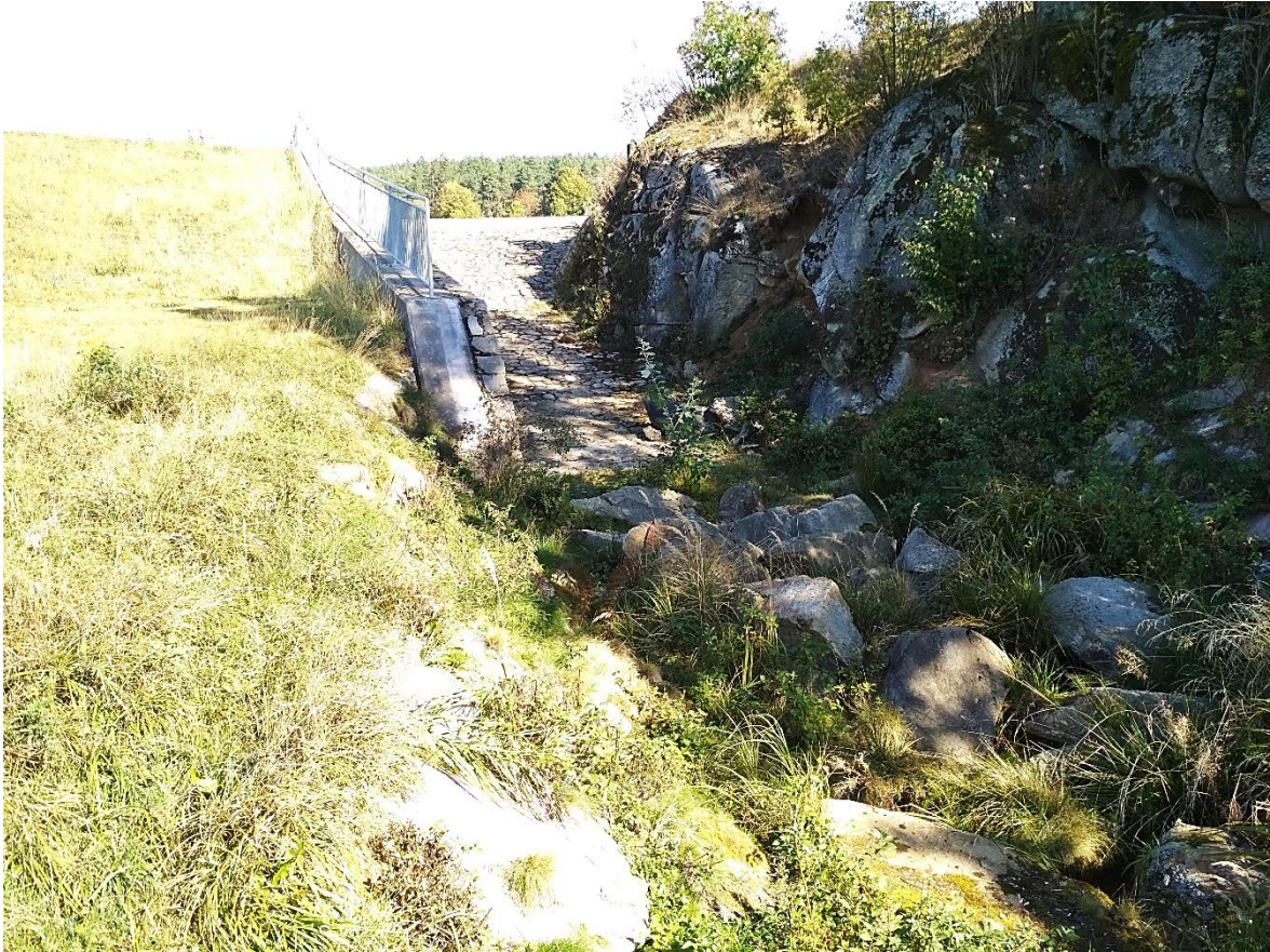
Obrázek 8.25 – Odpadní koryto bezpečnostního přelivu
