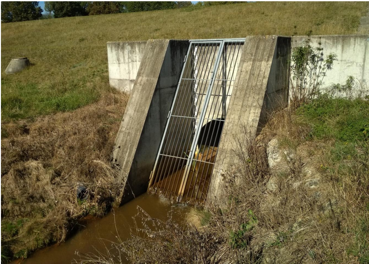
Obrázek 8.23 – Vyústění odpadního a drenážního potrubí
