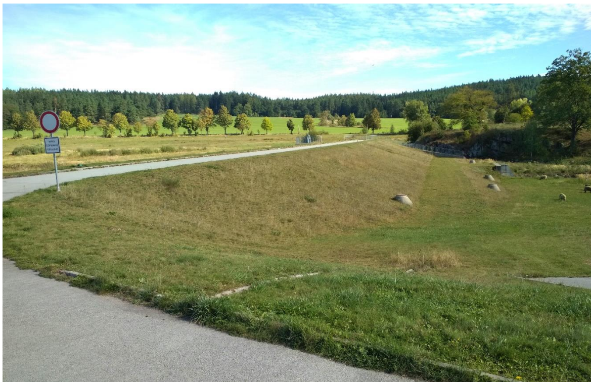
Obrázek 8.21 – Pohled na vzdušní svah hráze
