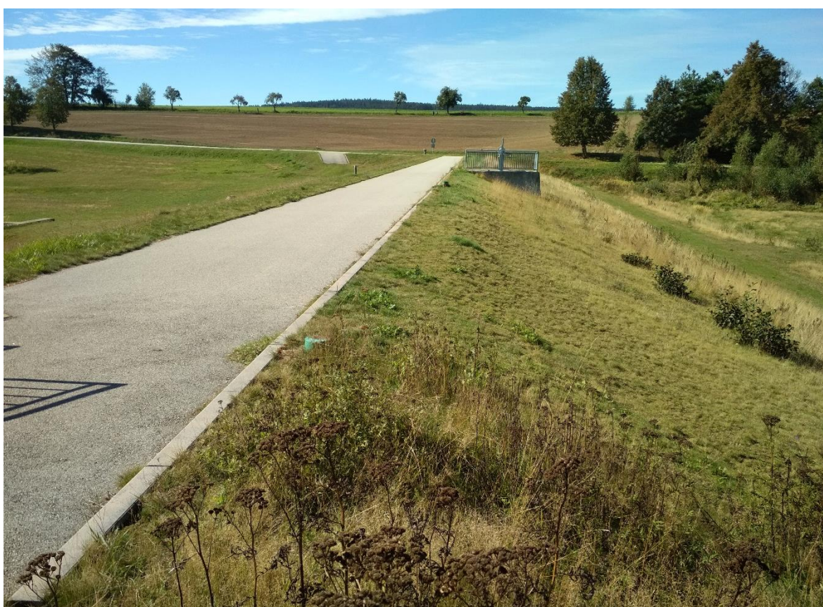
Obrázek 8.22 – Pohled na návodní svah hráze
