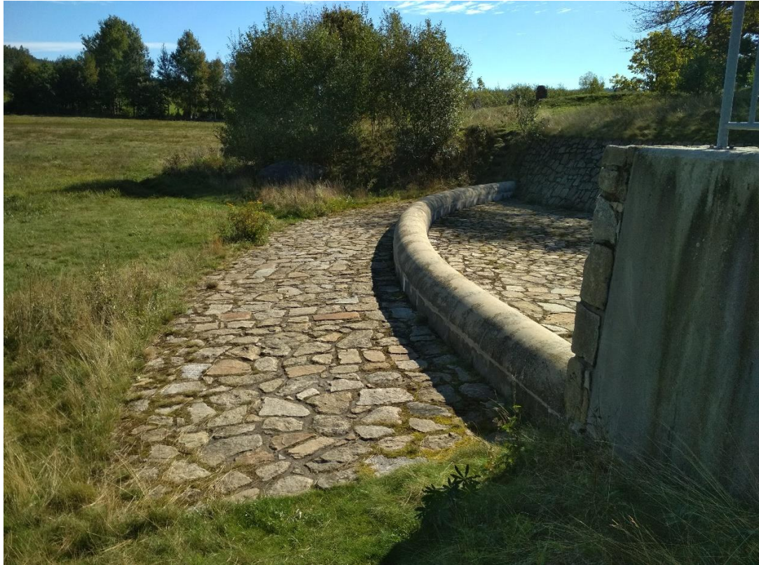
Obrázek 3.4 – Pohled na bezpečnostní přeliv (vlevo zátopa)
