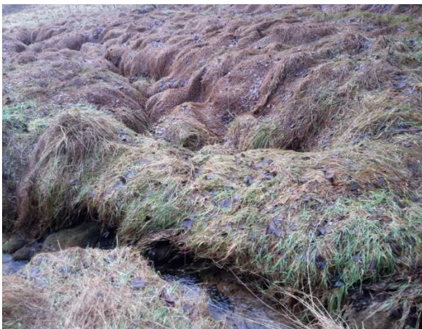
3.2.7 Zemní hrázka v místě rozdělení Hajného potoka zamezující vtoku vodoteče do pravého ramene toku.
