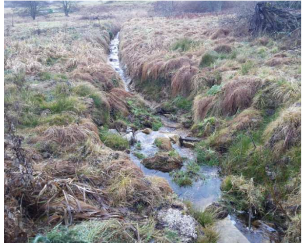
3.2.10 Pohled po vodě na začátku řešeného úseku Hajného potoka. V přední části výmol vytvořený vlivem eroze, dále pokračuje technicky upravené a později erozí prohloubené koryto.
