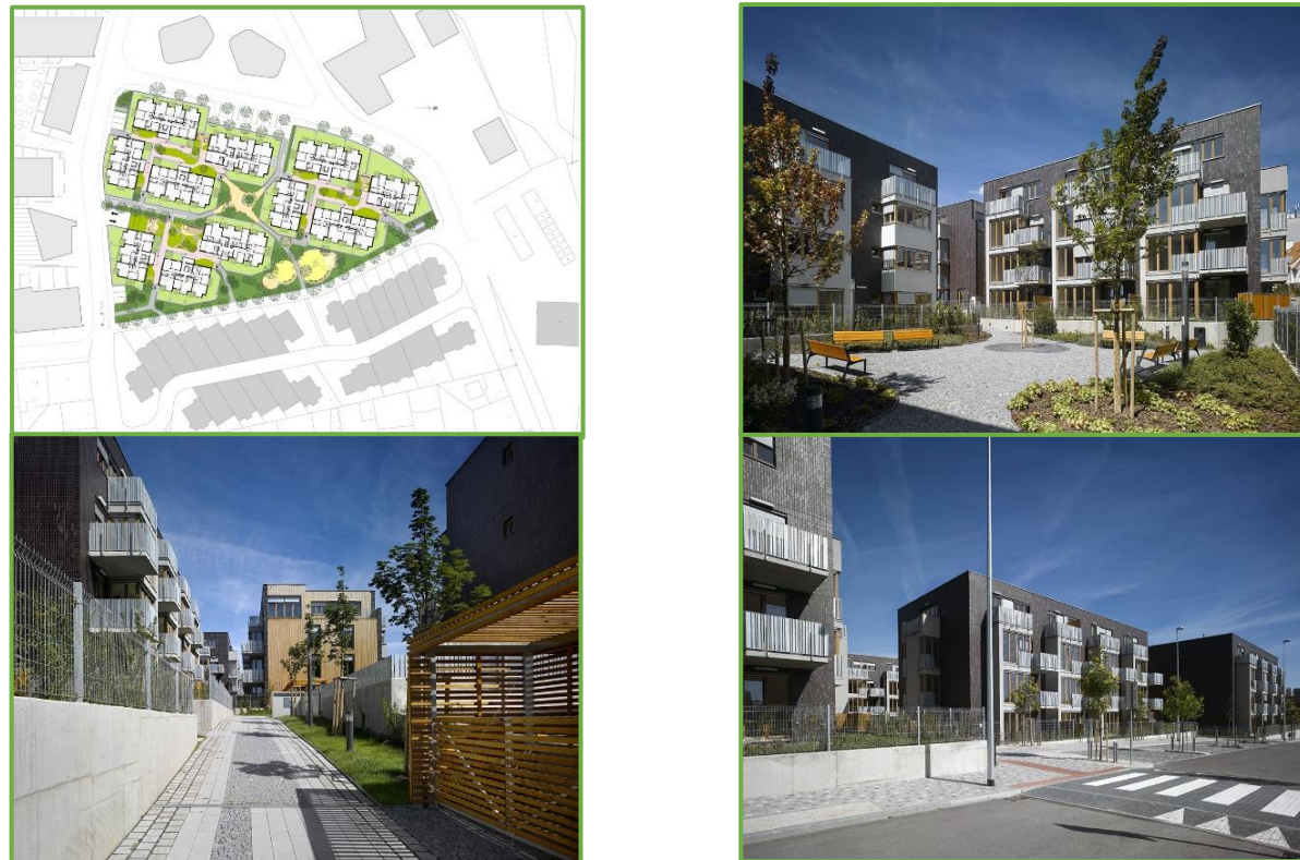
Obr. 17-20: Obytný soubor na Vackově (Zdroje: https://www.archiweb.cz/b/obytny-soubor-na-vackove-alfarezidence )
