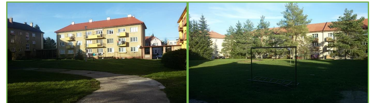
Obr. 56, 57: Vnitrobloky z 50. let 20. století v Přelouči (Zdroj: vlastní foto)
