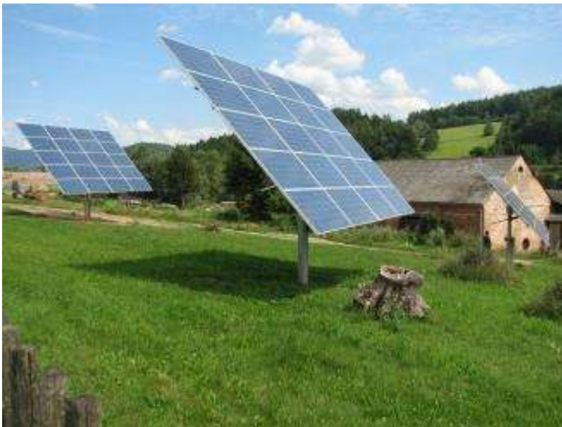
obr. 37 – Otočná nosná konstrukce [www.solarobchod.cz]
