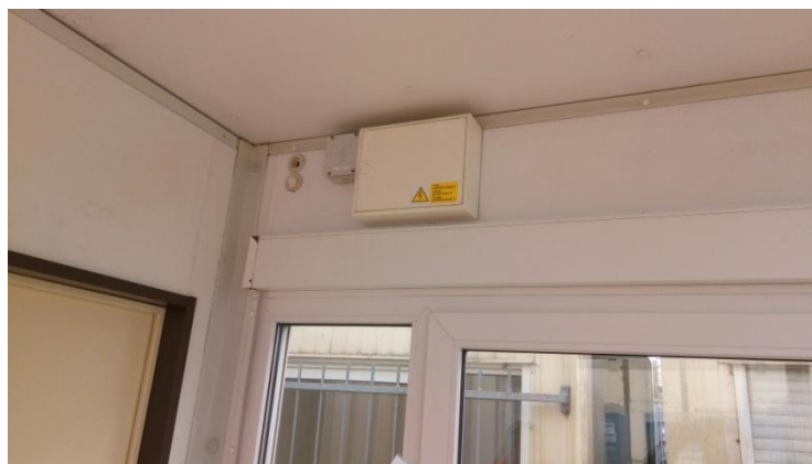
Obr. 23: Příklad umístění rozvaděče v modulu [Autor]
