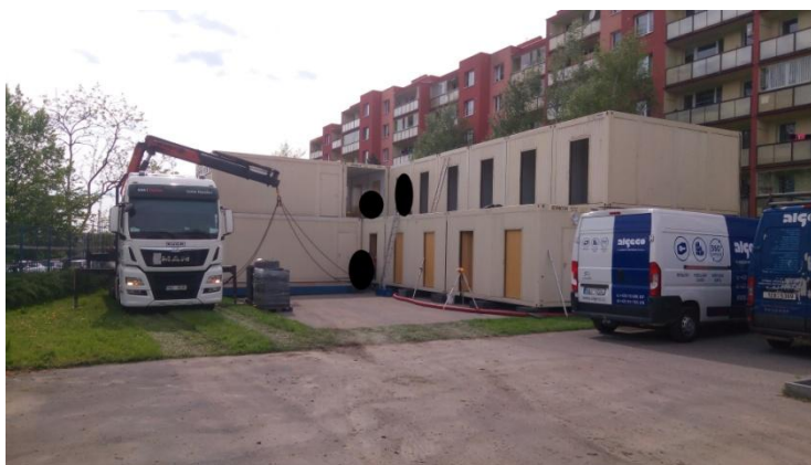
Obr. 38: Výstavba policejní stanice na Praze 14 [Autor]
