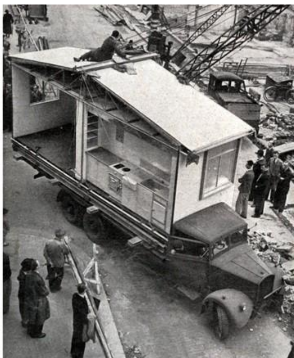
Obr. 9: Přeprava a montáž modulu rodinného domu AIROH [14]
