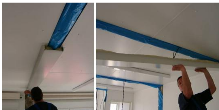
Obr. 32: Příklad krytu stropu s tepelnou izolací [40, str. 7]
