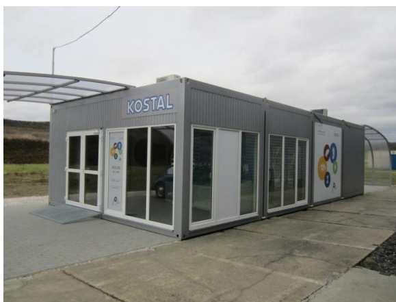
Obr. 40: Modulární stavba Kostal realizovaná společností Algeco [52]
