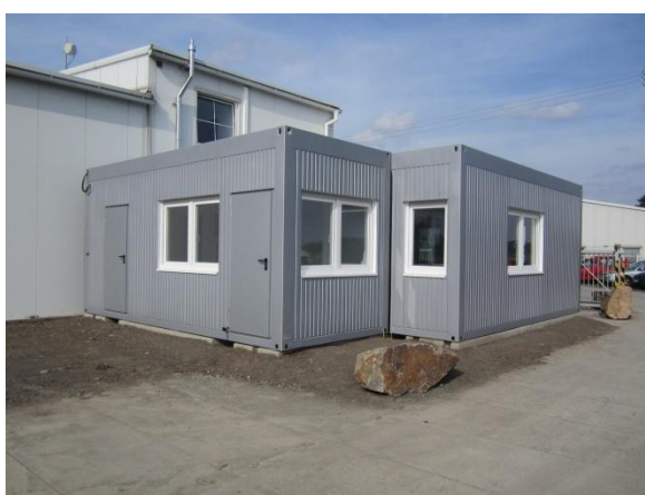
Obr. 41: Modulární stavba Geis realizovaná společností Algeco [52]
