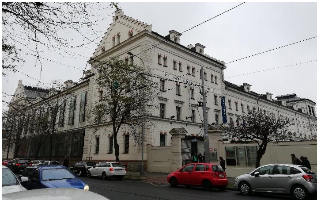
Obrázek 2 – Průčelí Holešovického pivovaru
