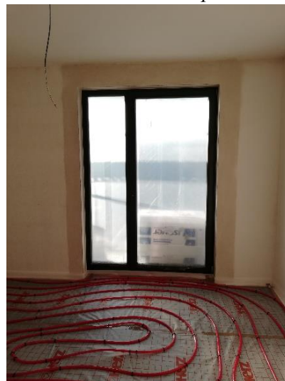
Obrázek 20 – Dodatečné omítnutí ostění a nadpraží
