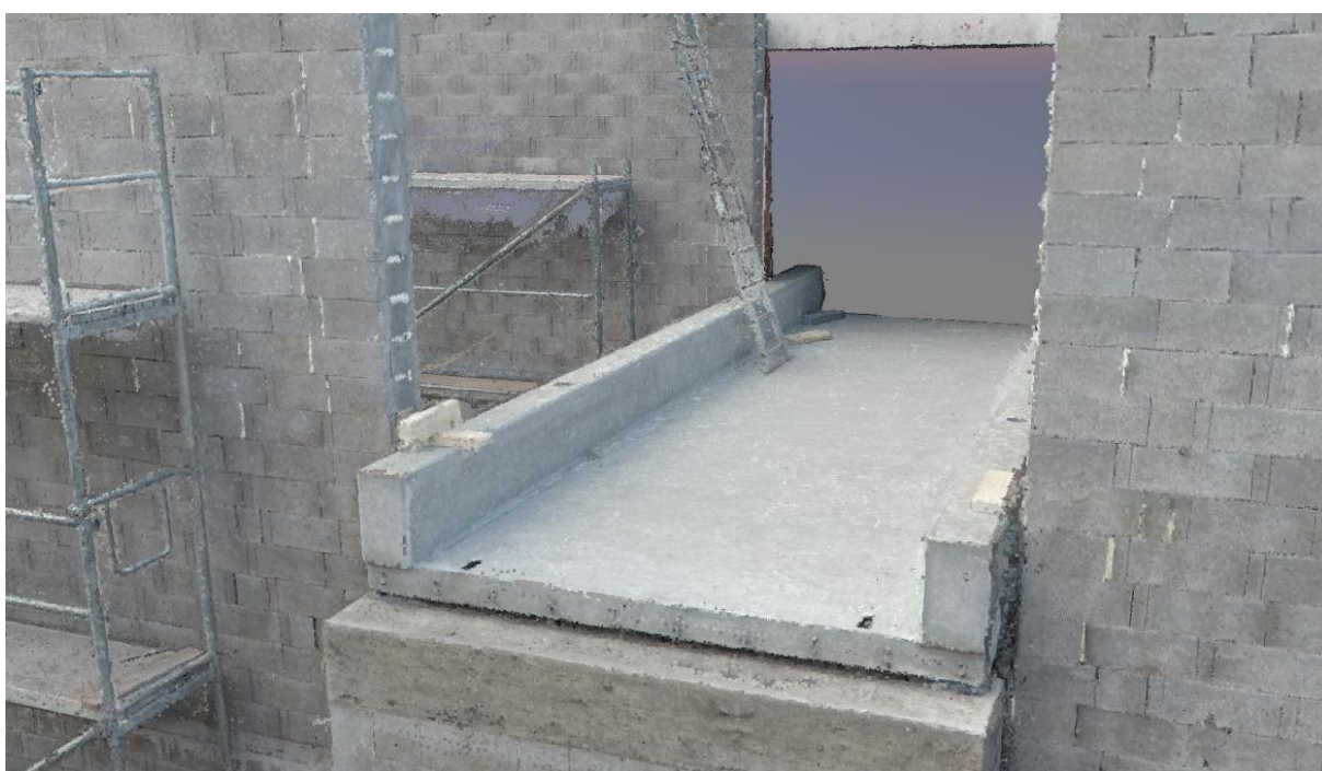
Obrázek 33: Mračno bodů v místě prefabrikované mostovky
