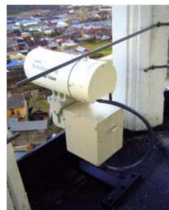
*obr. 18 Videodetekce požáru ve venkovním prostředí [26]*
