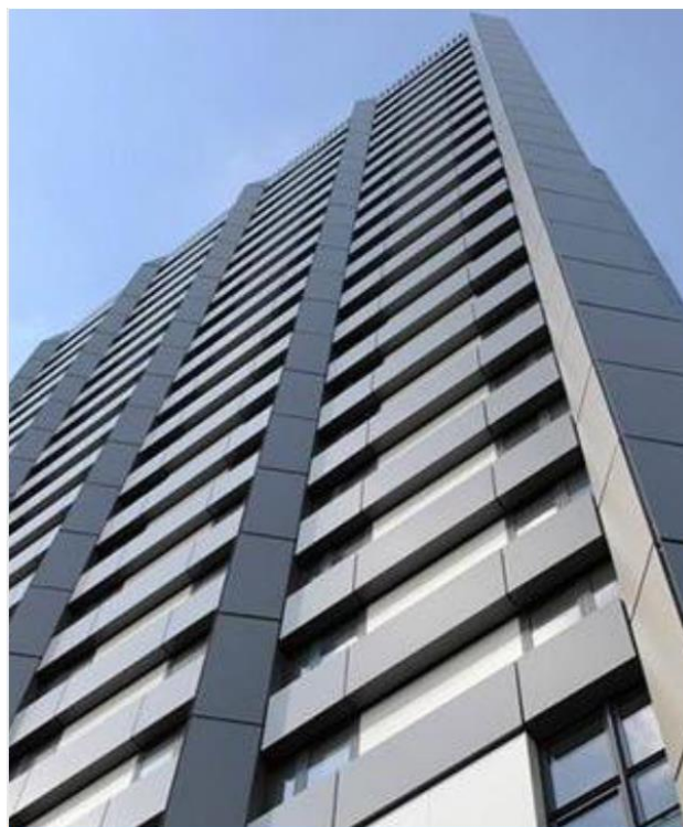
obr. 17 Pohled na budovu, pilíře fungovaly jako komíny [17]
