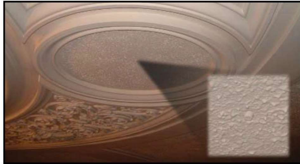
Obr.12 Nasávací otvor v divadelním stropě [11]
