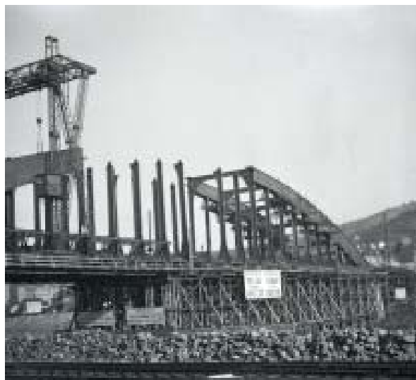
Obrázek 4 – Montáž ocelové konstrukce (1935)
