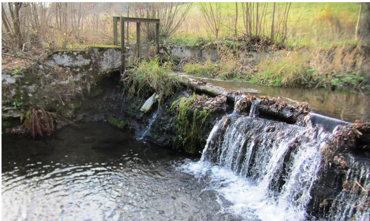
Těleso jezu a štěrková propust
