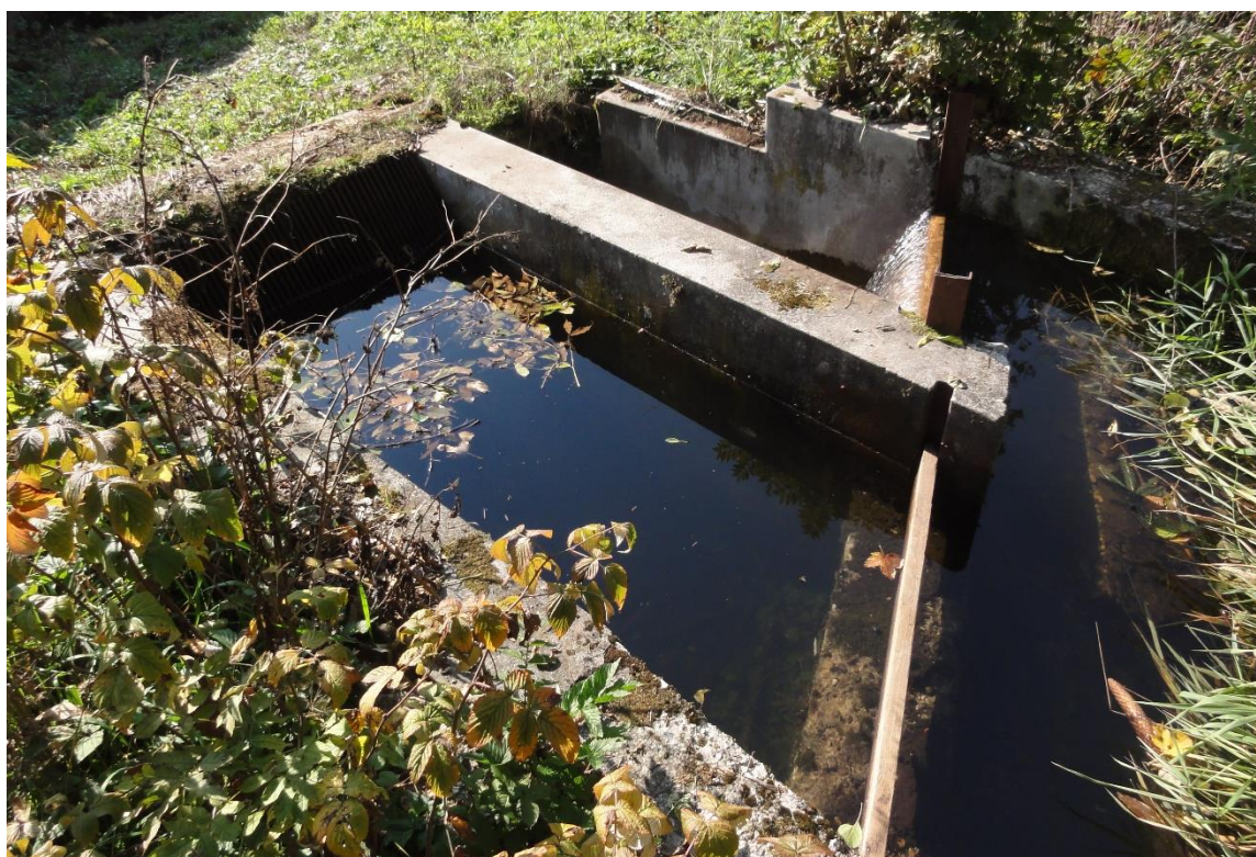
Stávající jemné česle na vtoku do turbíny a jalový kanál
