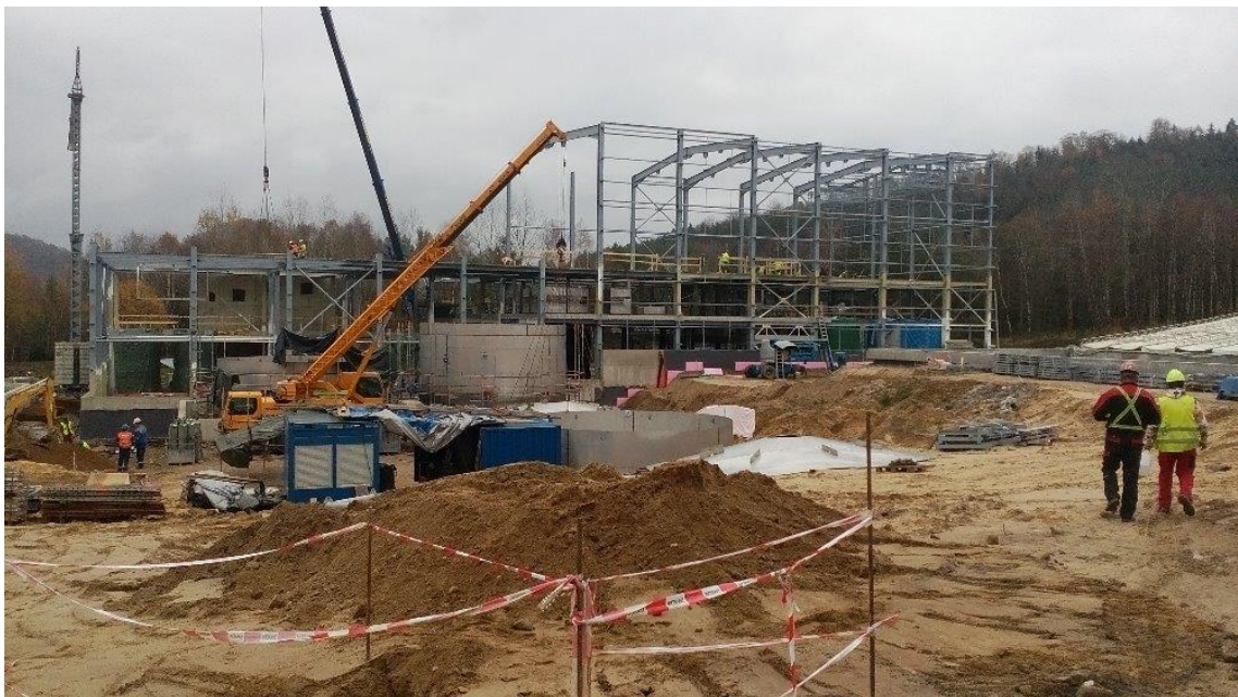
Obr. 9 – Rekonstrukce technologie NDS 6 v o. z. TÚU (vlastní zdroj)
