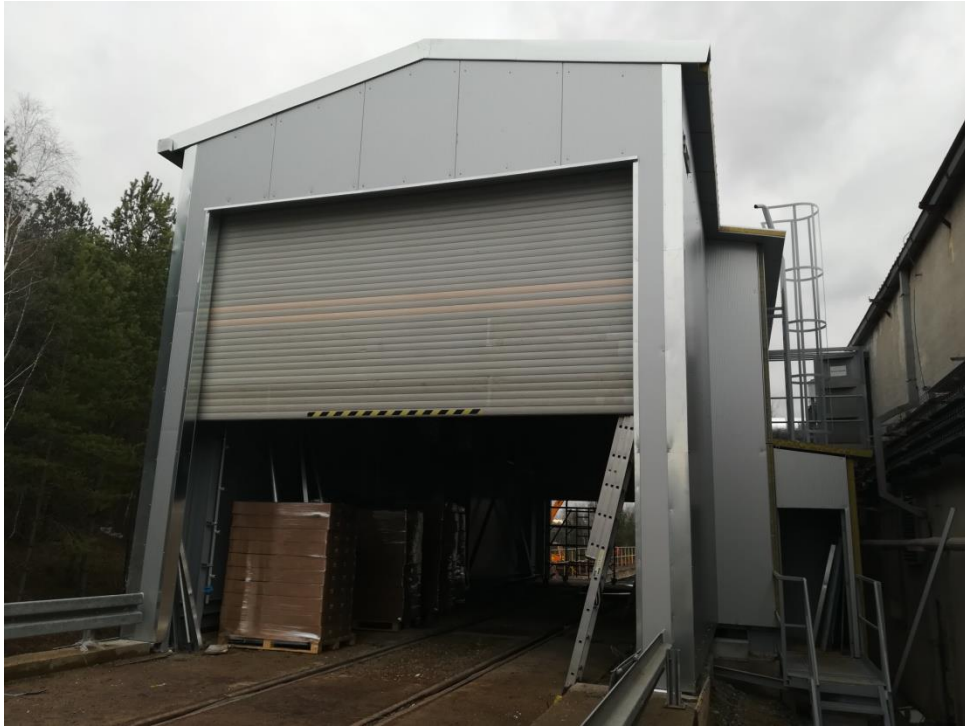
Obr. 11 – Dokončení rekonstrukce stáčecího místa skladu chloru (vlastní zdroj)
