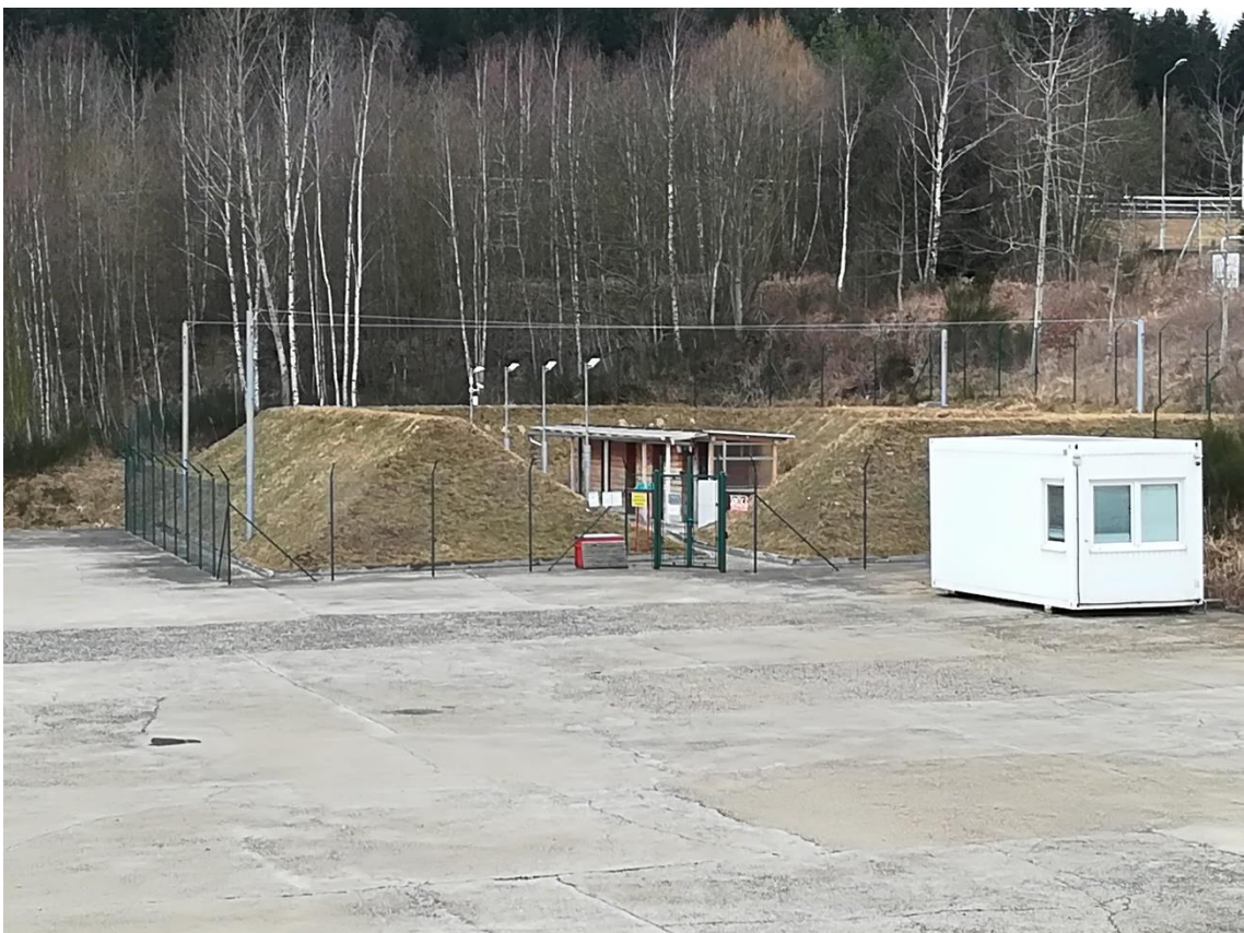
Obr. 6 - Povrchový sklad výbušnin SMK (vlastní zdroj)
