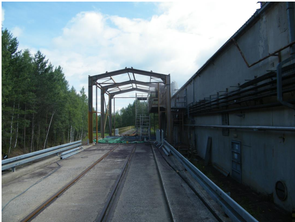
Obr. 10 – Počátek rekonstrukce stáčecího místa skladu chloru (vlastní zdroj)
