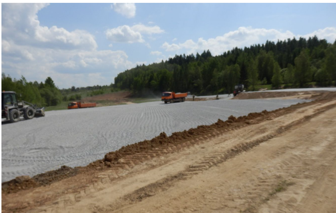
Obrázek 2: Příprava podloží pro výstavbu stanového tábora
