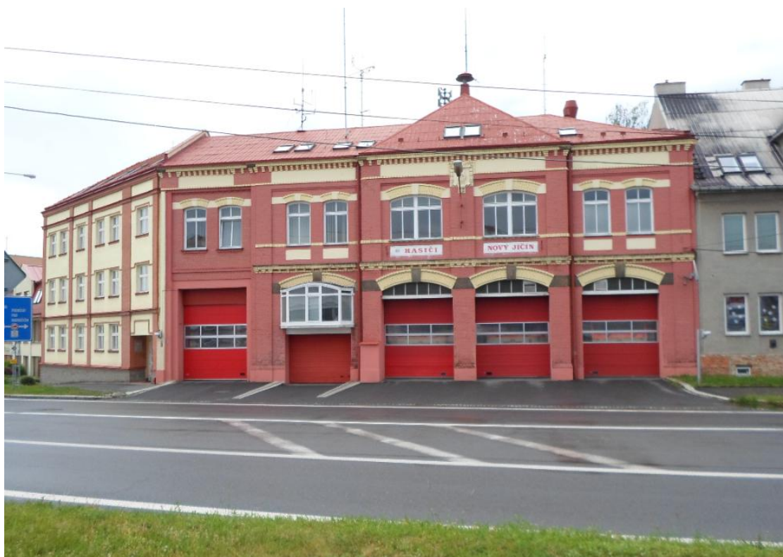
Obrázek 12: Centrální hasičská stanice Nový Jičín - garážová stání s výjezdem do ulice Zborovská
