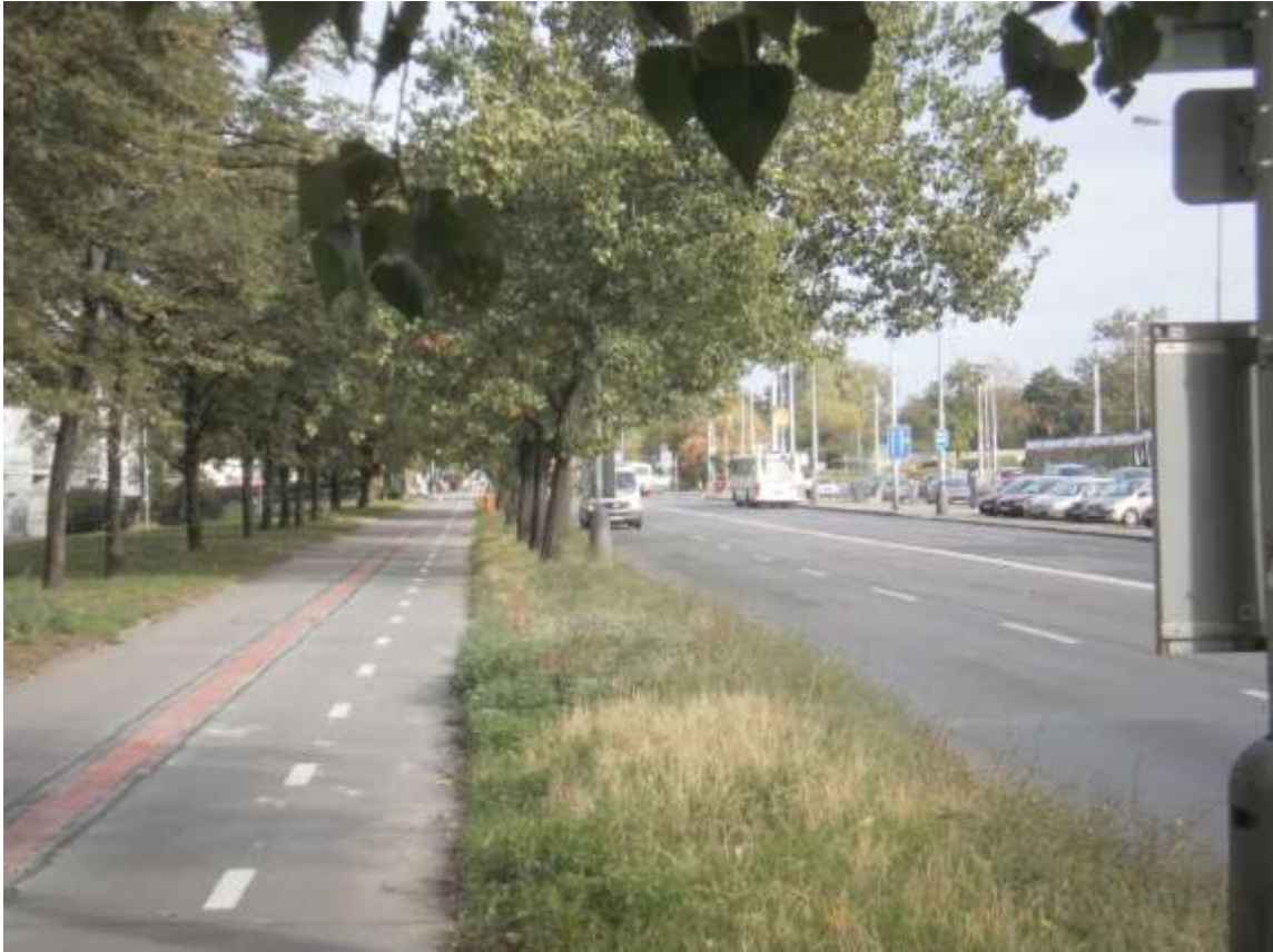
Obrázek č.23 – Pohled na pás rostlých stromů s větvemi nad vozovkou (foto - archiv autora)
