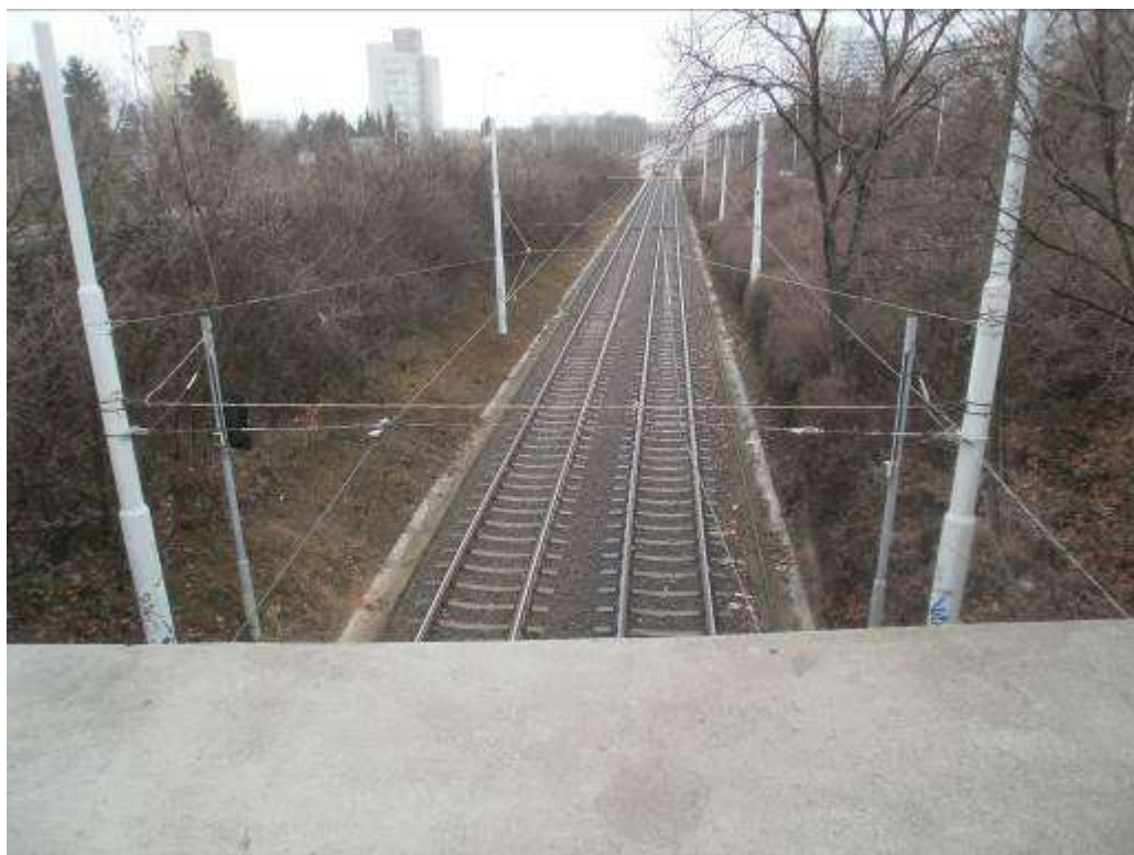
Obrázek č.14 - Pohled na betonovou zídku spolu s podzemní tramvajovou tratí (zdroj: archiv autora)
