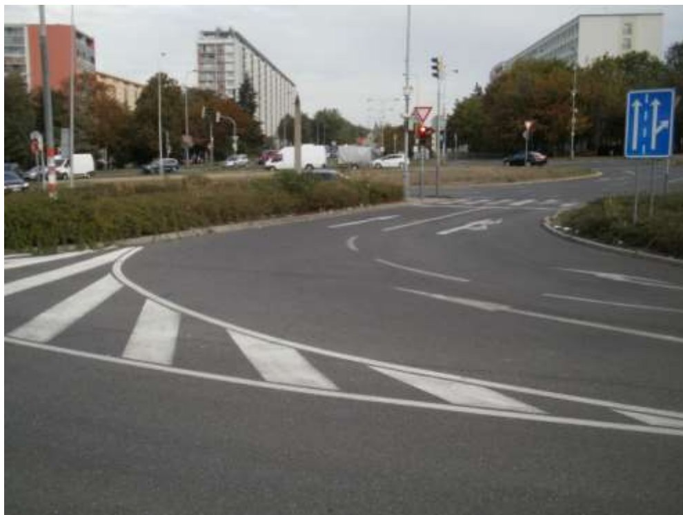
Obrázek č.21 – Pohled na nevhodné uspořádání výjezdu z Kauflandu (zdroj: archiv autora)
