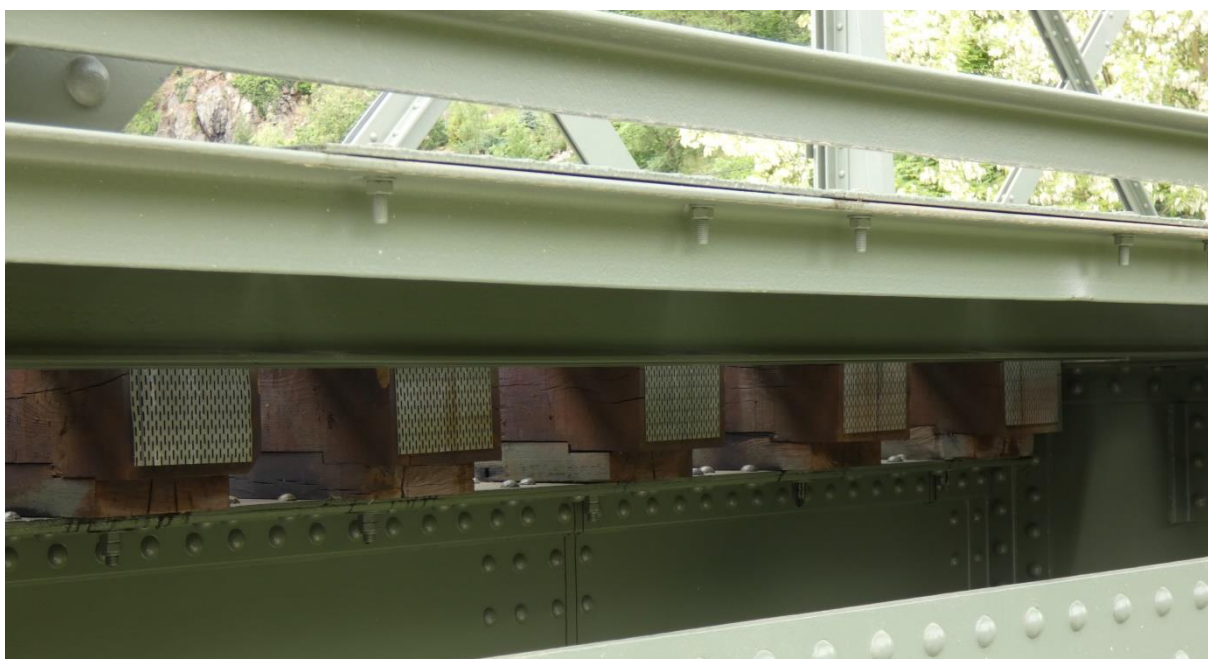
Obrázek 9: Nová prvková mostovka u zastávky Borač – most přes řeku Svatku
