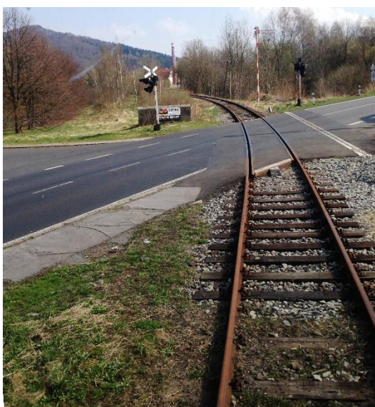
Obrázek 13 Pohled na přejezd P9189 od České Kamenice.
