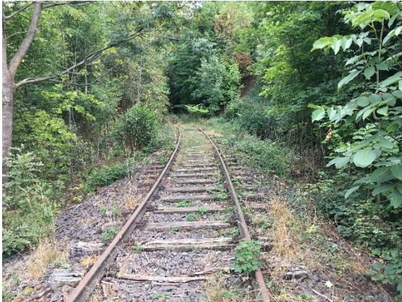
Obrázek 17 Zachovalý železniční svršek přibližně v km 0,350 obnovovaného úseku.
