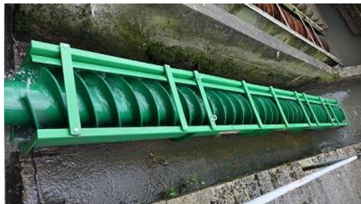
Obrázek 22 - Šnekové čerpadlo 2
