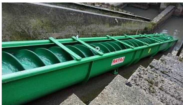
Obrázek 21 - Šnekové čerpadlo
